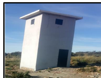
Figure 161 : Un poste d'électricité. (Source : photo prise par l'auteur, 2020).
