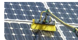
Figure 271 : Entretien des Capteurs solaires. (Source : https://www.ungerglobal.com/fr/applications/nettoyage-panneaux-solaires ).
