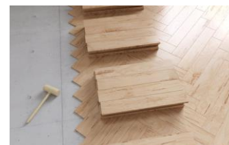
Figure 287 : parquet sur du carrelage. (Source :
