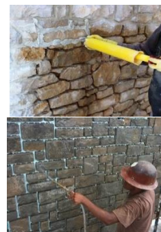
Figure 272 : Entretien des murs en pierre.
