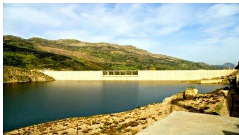
Figure 104 : Barrage Mefrouch. (Source : l'auteur).
