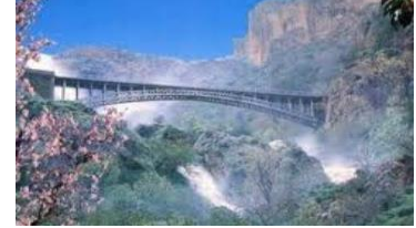
Figure 129 : pont métallique - Gustave Eiffel .(Source : photo prise par l'auteur, 2020).
