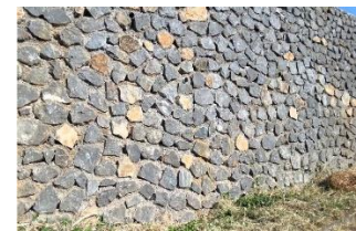
Figure 276 : Mur porteur en pierre naturelle « moellon ».
