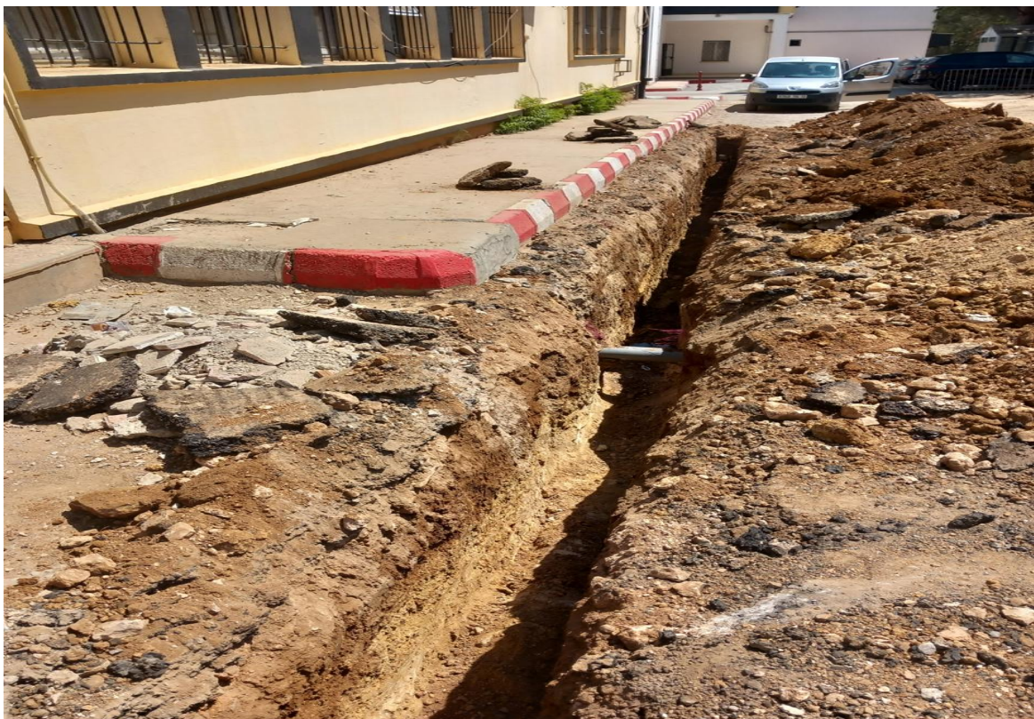
Figure IV.4 : Travaux de terrassement de la tranchée
