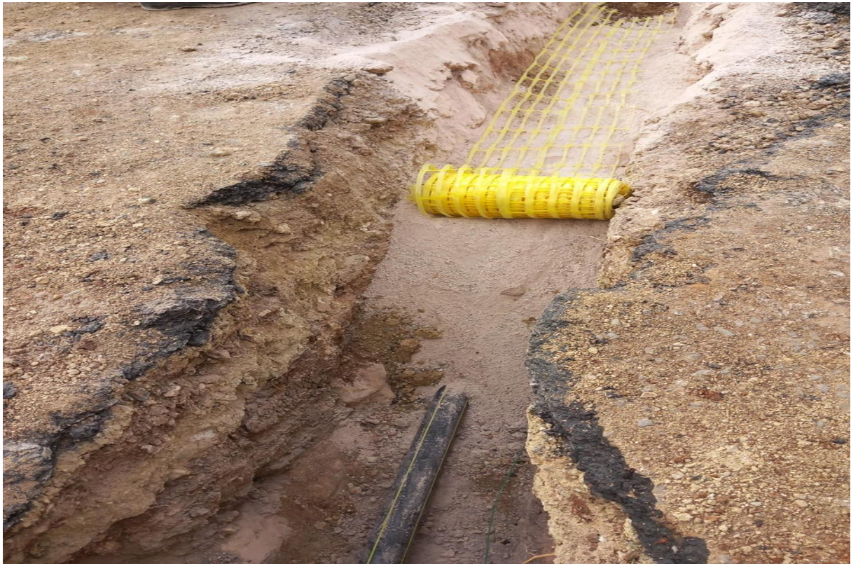
Figure IV.11 : Remblaiement et pose du grillage avertisseur
