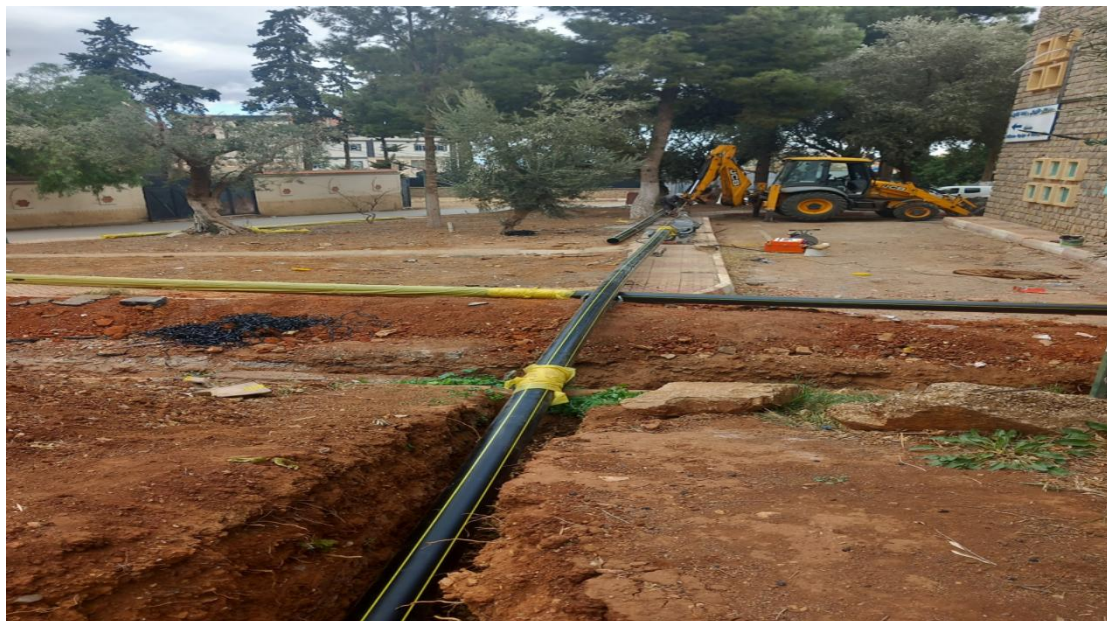
Figure IV.6 : Pose des canalisations en PEHD
