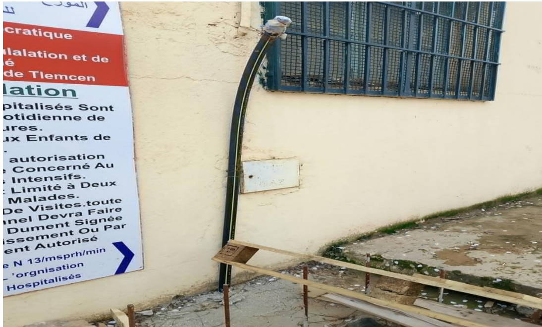
Figure IV.9 : Réalisation des branchements
