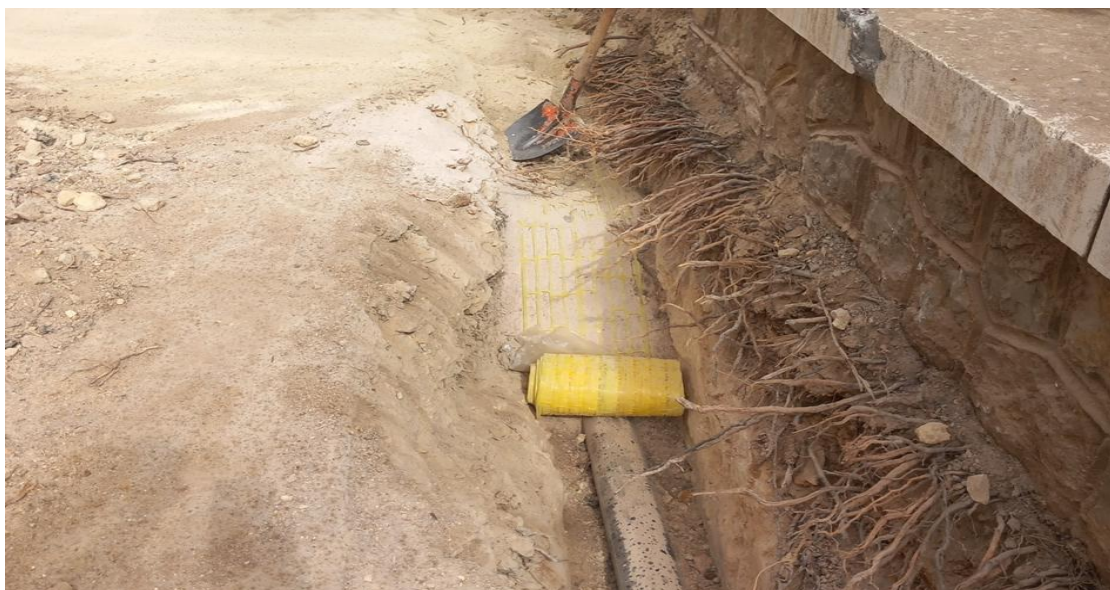
Figure IV.10 : Enrobage des canalisations
