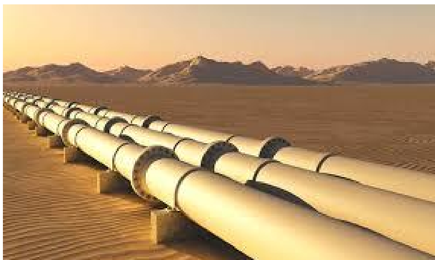
Figure I.5 : Canalisations (gazoducs) pour réseau transport gaz
