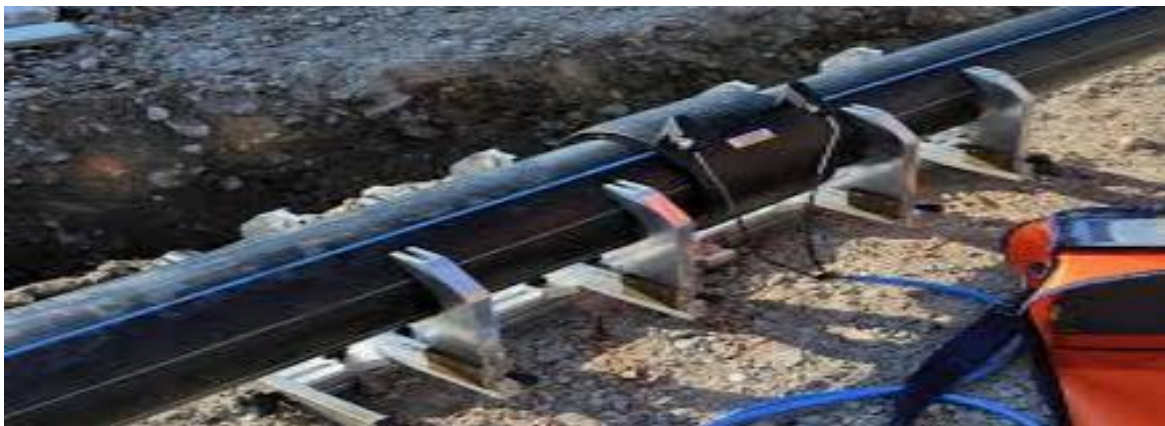
Figure I.20 : Électrofusion des tubes en PEHD
