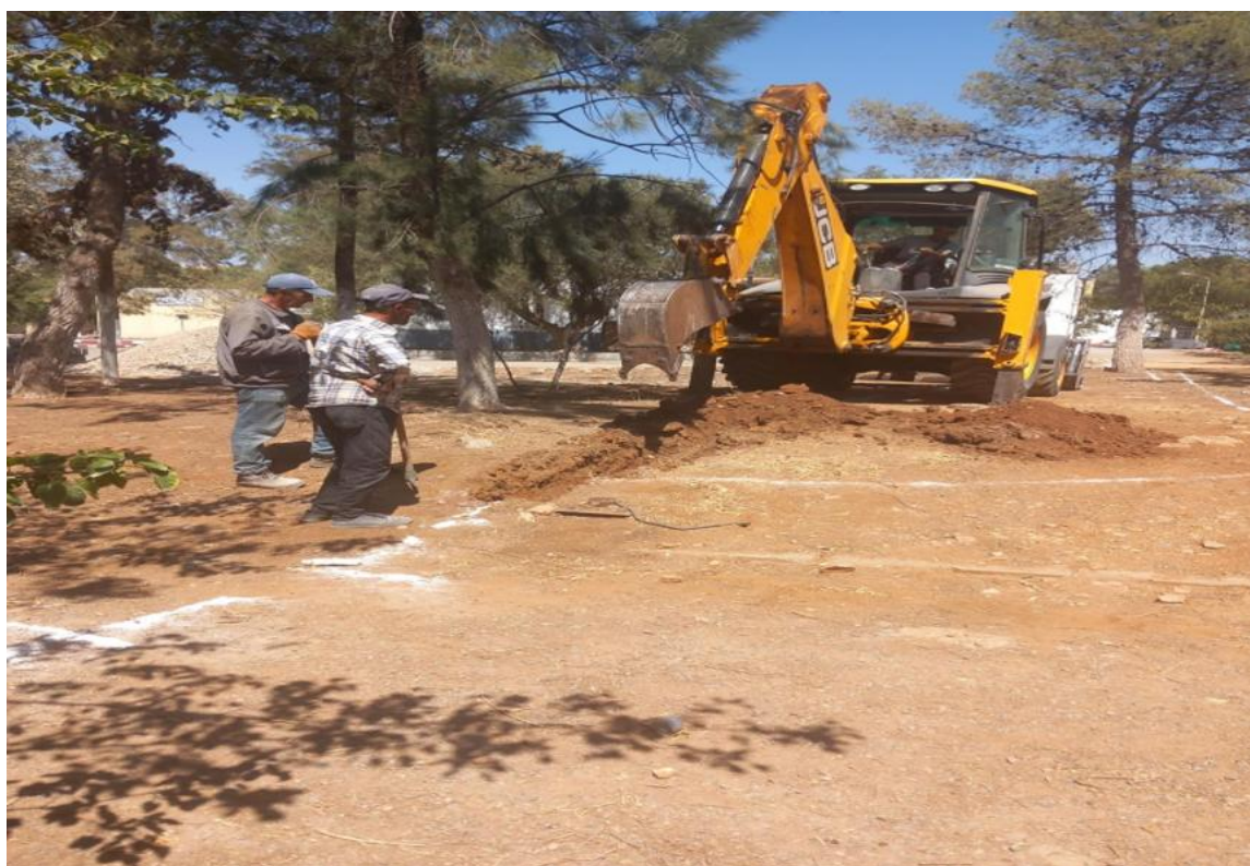
Figure IV.2 : ouverture de tronché
