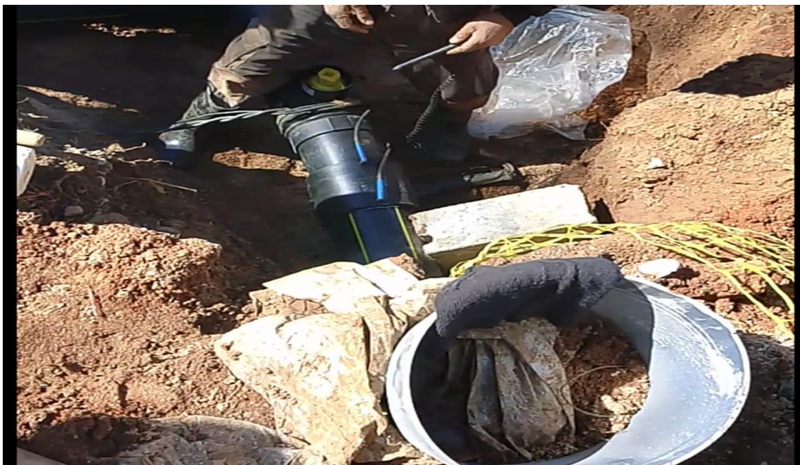
Figure IV.8 : Opération de soudage des conduites
