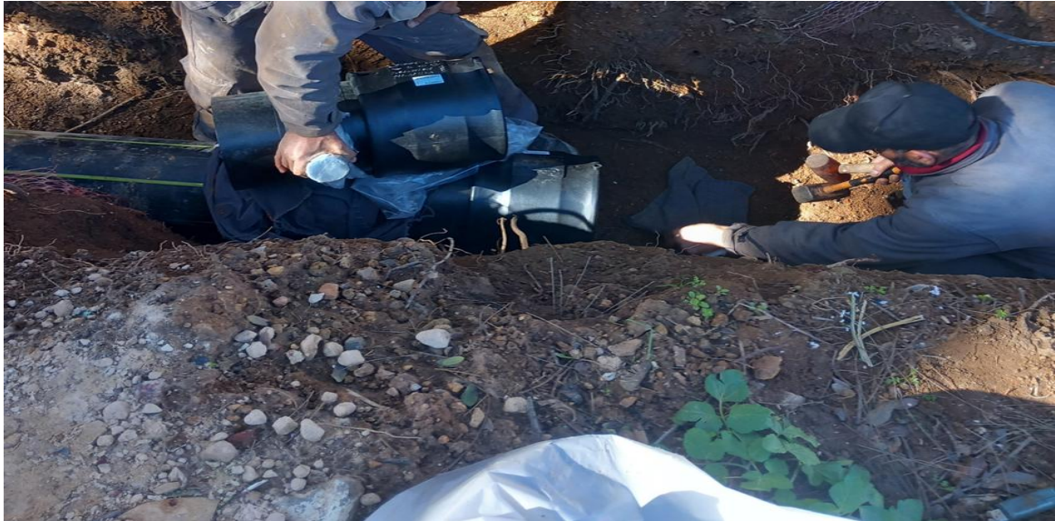
Figure IV.7 : Assemblage par électrofusion
