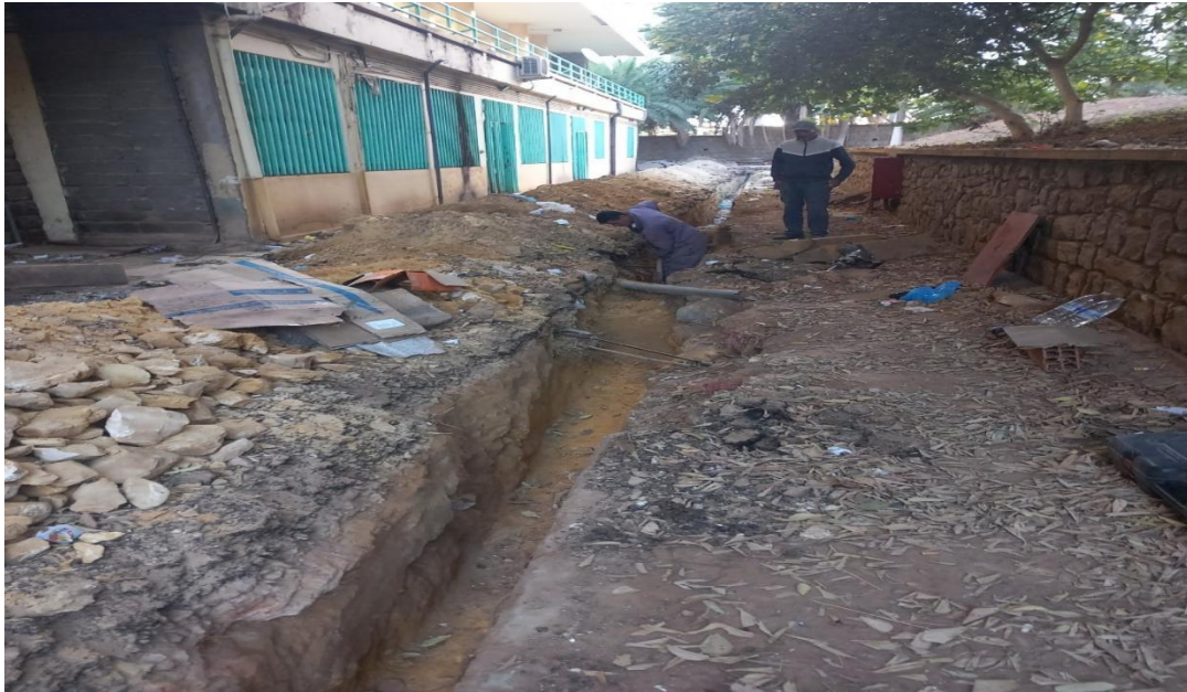
Figure IV.5 : Réalisation du lit de pose en sable
