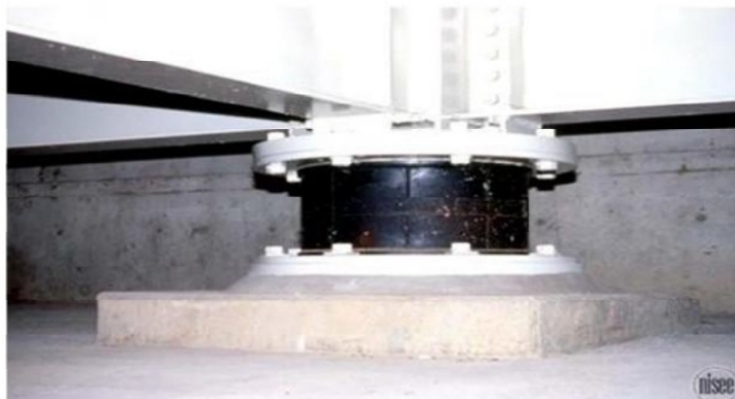
Figure 1.12 : isolateur de caoutchouc a fort amortissement du bâtiment de réserve d'urgence de conty los angeles . [2]
