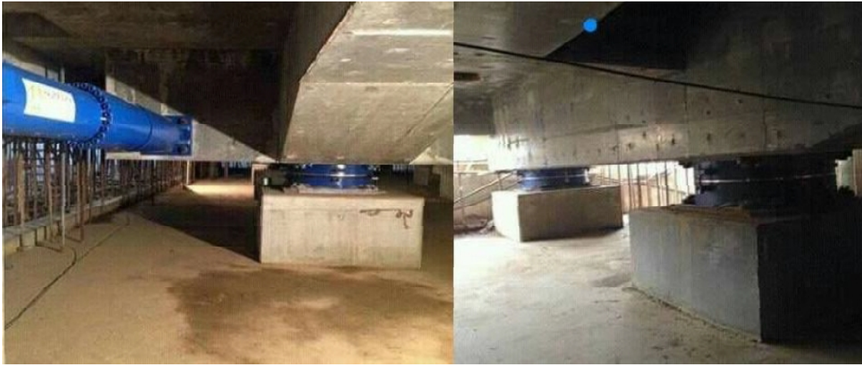
Figure 2.9 : Système d'isolation de base
