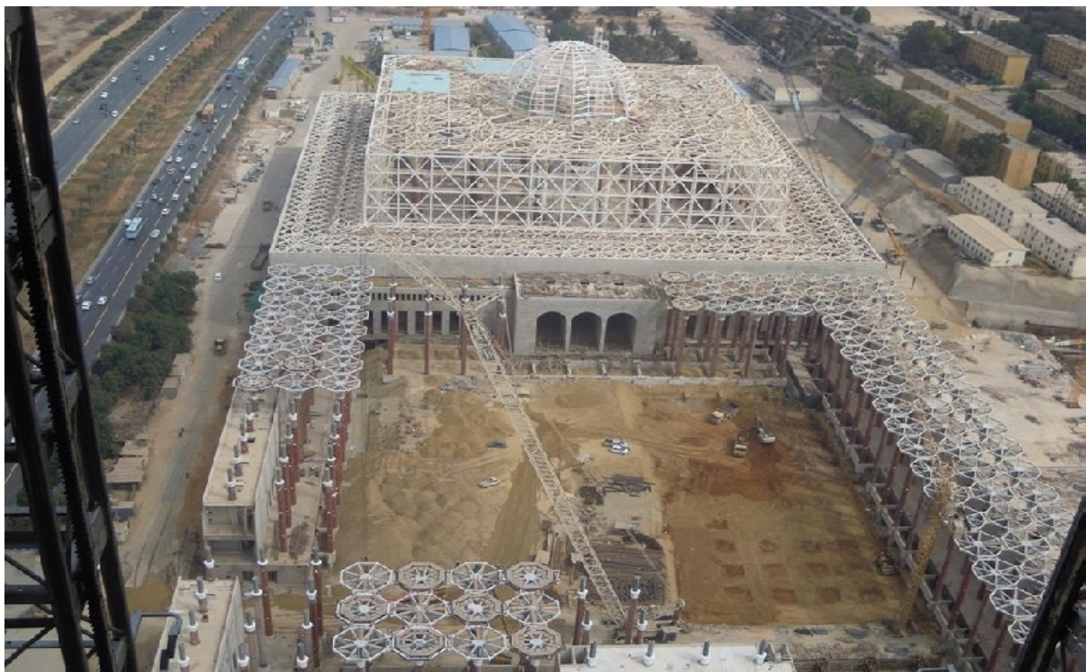
Figure2.5 : la salle de prière en cours de construction
