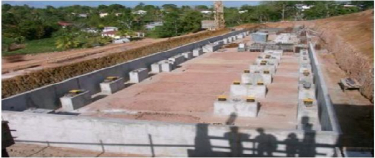
Figure 1.2 : mise en place des isolateurs les massifs d'une structure [1].
