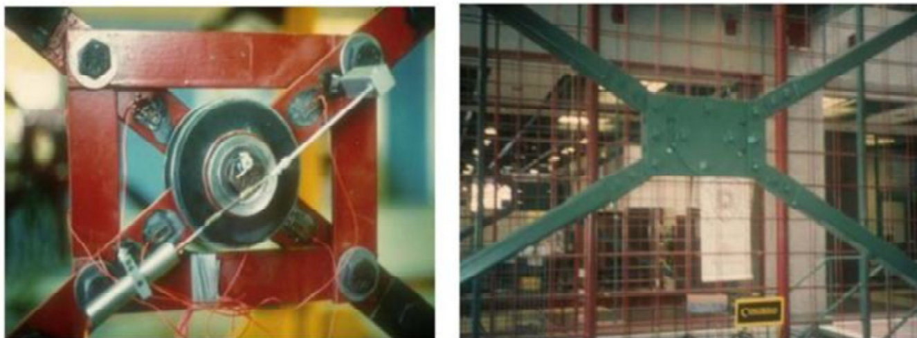
Figure 1.24 : l'amortisseur de pall et son installation
