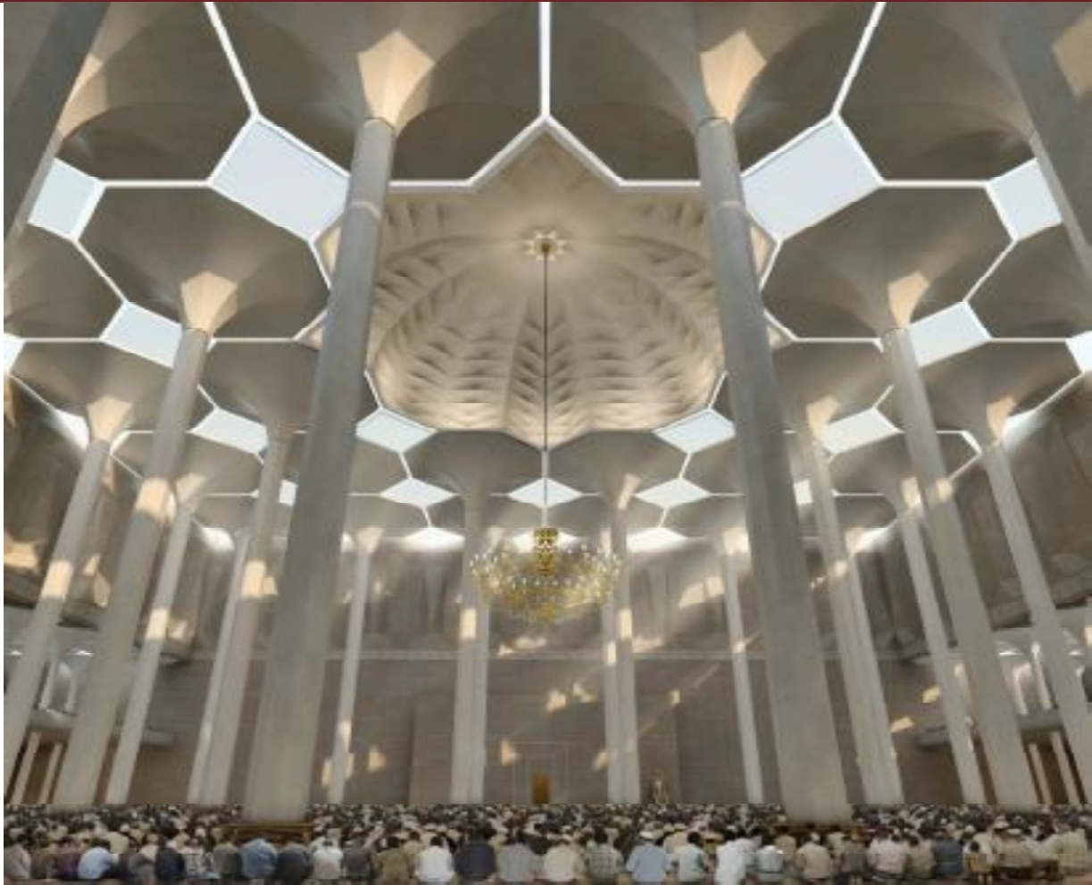
La Figure 2.7 : montre les colonnes utilisées dans la salle de prière de la grande Mosquée d'Alger.
