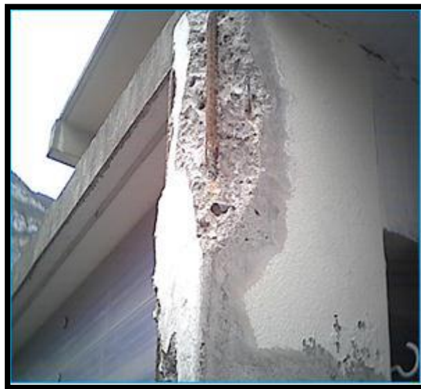
Figure I.4 : Dégradation des éléments d'un ouvrage par carbonatation
