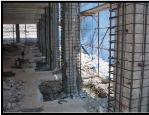
Figure I.7 : chemisage en béton armé [7]
