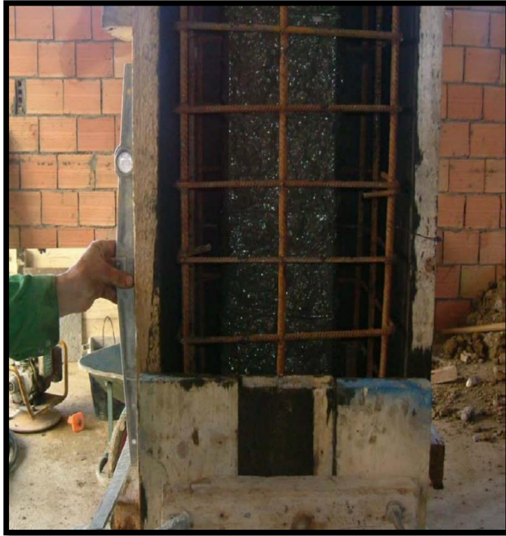
Figure II.12 : Coffrage du chemisage [16]
