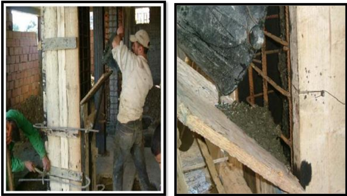
Figure II.13 : Coulage du béton [16]
