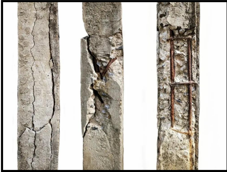
Figure I.3 : Carbonatation du béton d'enrobage
