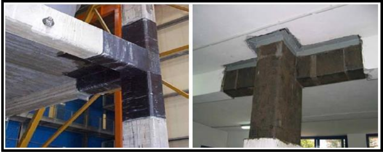
Figure I.20: Renforcement des nœuds par chemisage en FRP [17]
