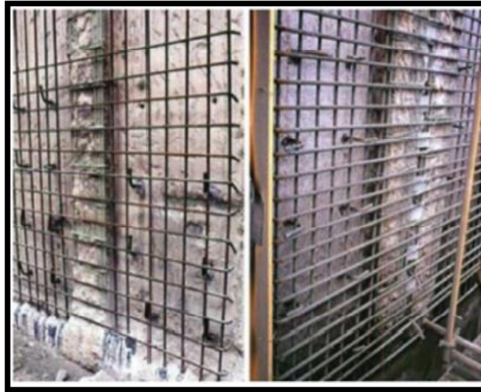
Figure I.12: Chemisage sur voile [10]
