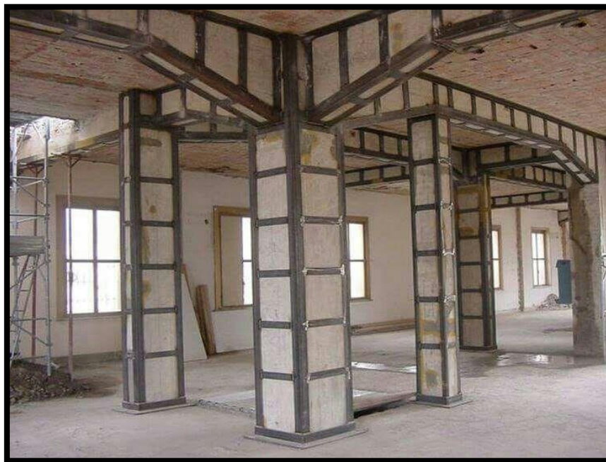
Figure I.16 : Renforcement d'une structure par chemisage en acier [8]
