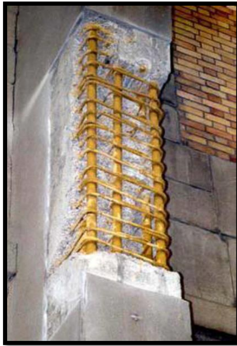
Figure II.7 : Réfection des bétons et protection des armatures (Hicham BELHANNACHI, 2009)
