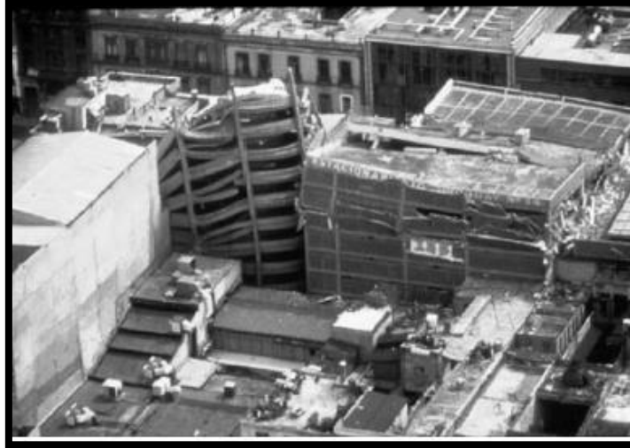
Figure II.4 : Séisme de 1985 à Mexico effondrement vertical d'un immeuble [27]
