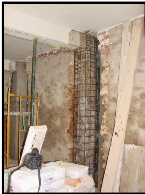
Figure I.8 : Chemisage d'un poteau en Béton armé [8]
