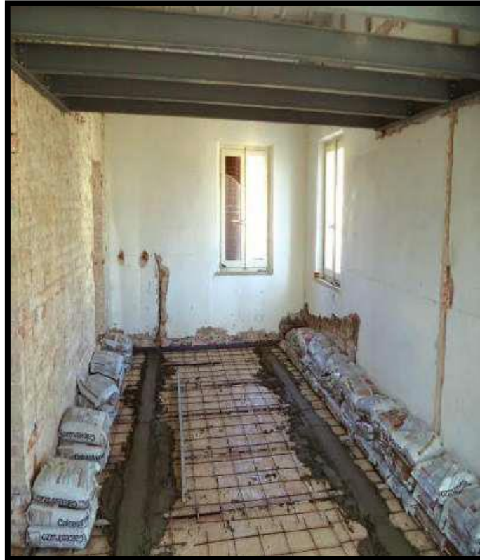
Figure I.14 : Renforcement de plancher par béton armé [9]
