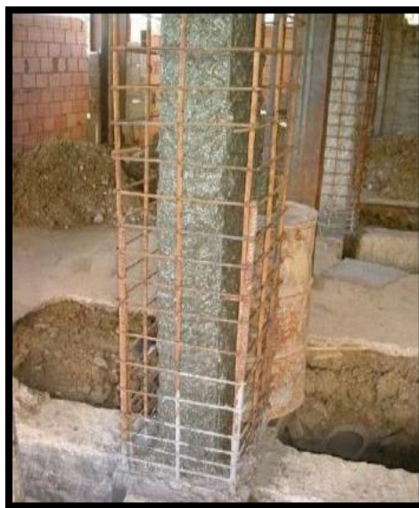
Figure I.2 : Chemisage d'un poteau en Beton arme [16]
