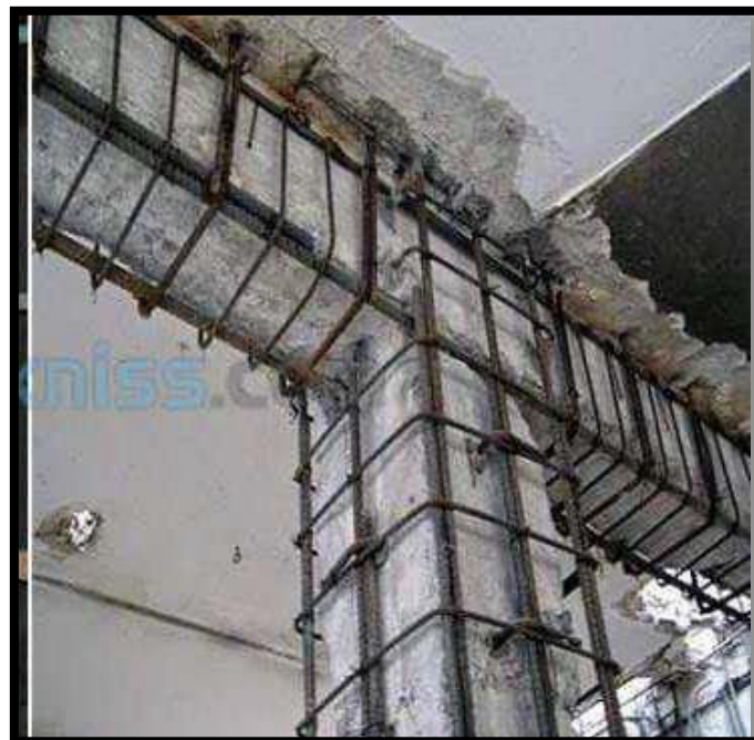
Figure I.11: Chemisage d'une poutre en Beton arme [6]
