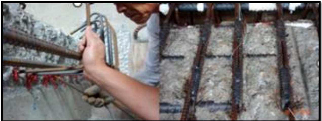
(a) Installation postérieure des armatures
