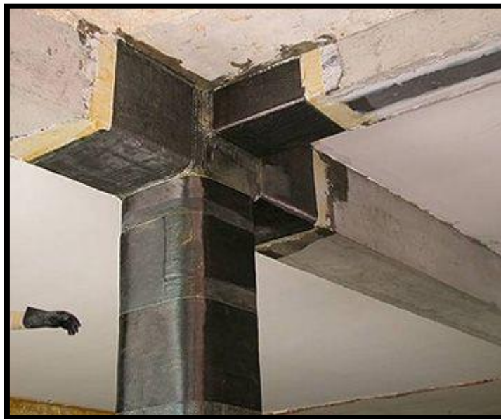
Figure I.19: Chemisage en fibre de carbone [8]
