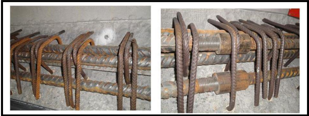
Figure II.8 : Renforcement avec ajout d'armatures (SEKHRI KHADIDJA, 2024)
