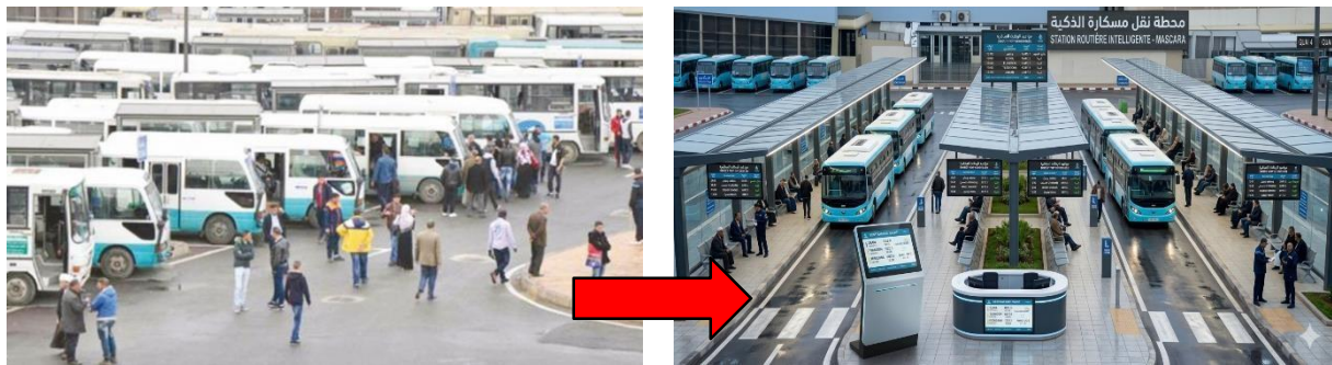
Figure 62 : modernisation de gare routière
