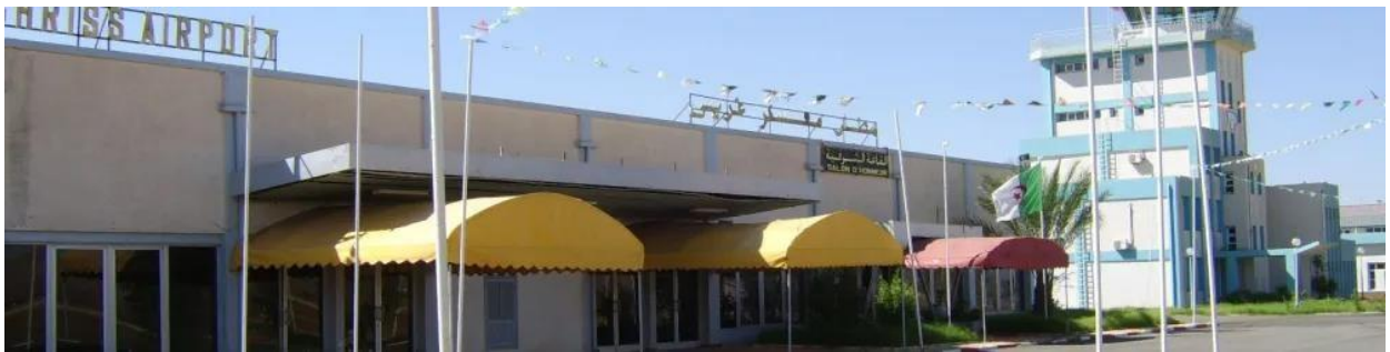
Figure 28: aéroport de Mascara ( source : « https://harba-dz.com » )
