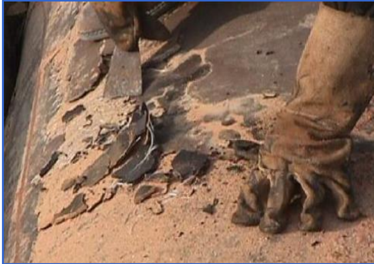
Figure II. 8 : Décapage manuelle (STT).
