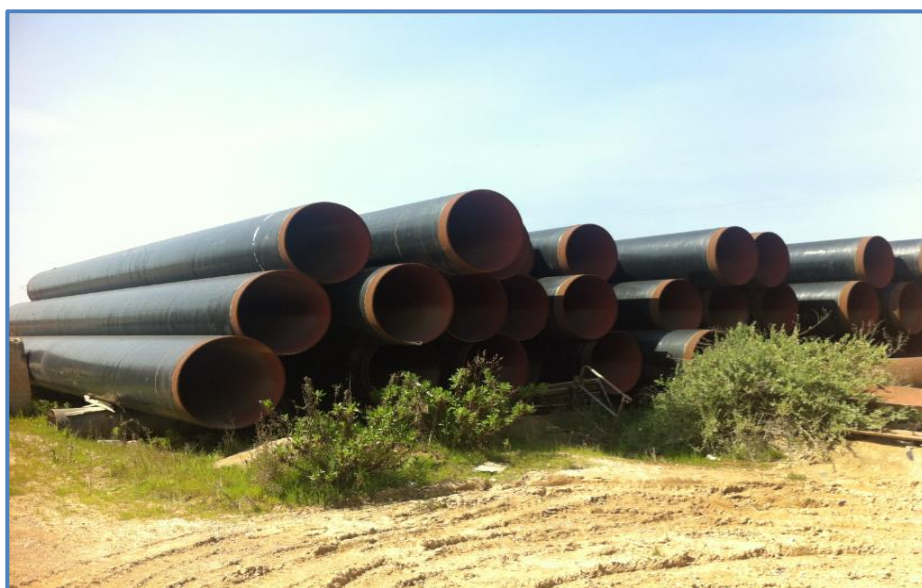
Figure I. 1 : pipelines à l'état de stockage (STT) station de traitement des tubes Sonatrach.
