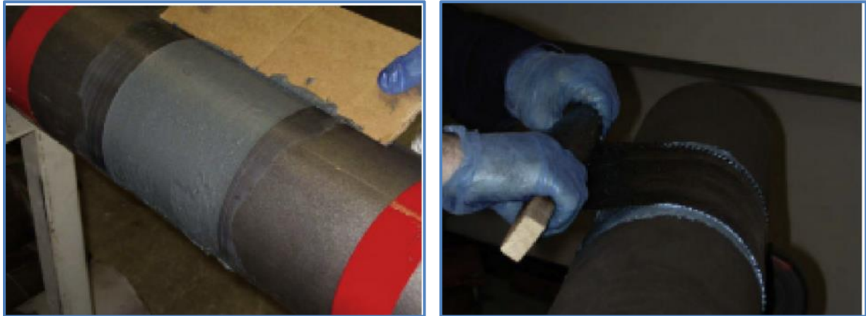
(a) Remplissage défaut avec du mastic
