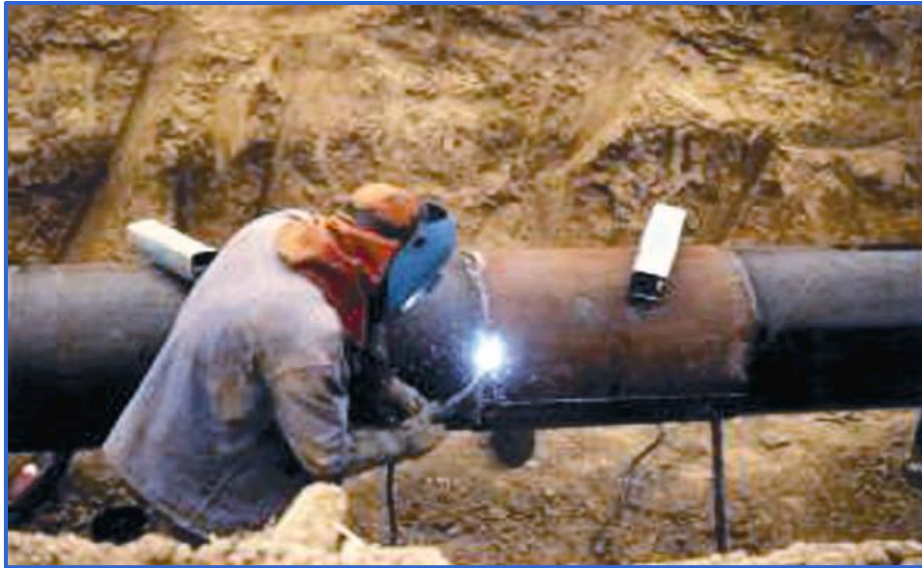
Figure II. 12 : Opération de soudages de demi coquilles (STT).
