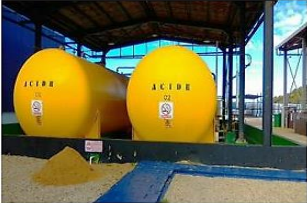
Figure IV. 12 : Bâtiment d'acide sulfurique, 17 mars 2025.
