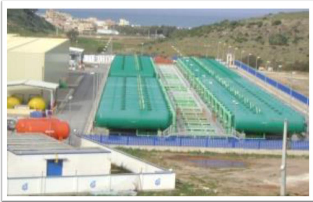
Figure IV. 13 : zone des filtres à sable et à anthracite de la SDEM de Béni Saf. [42]
