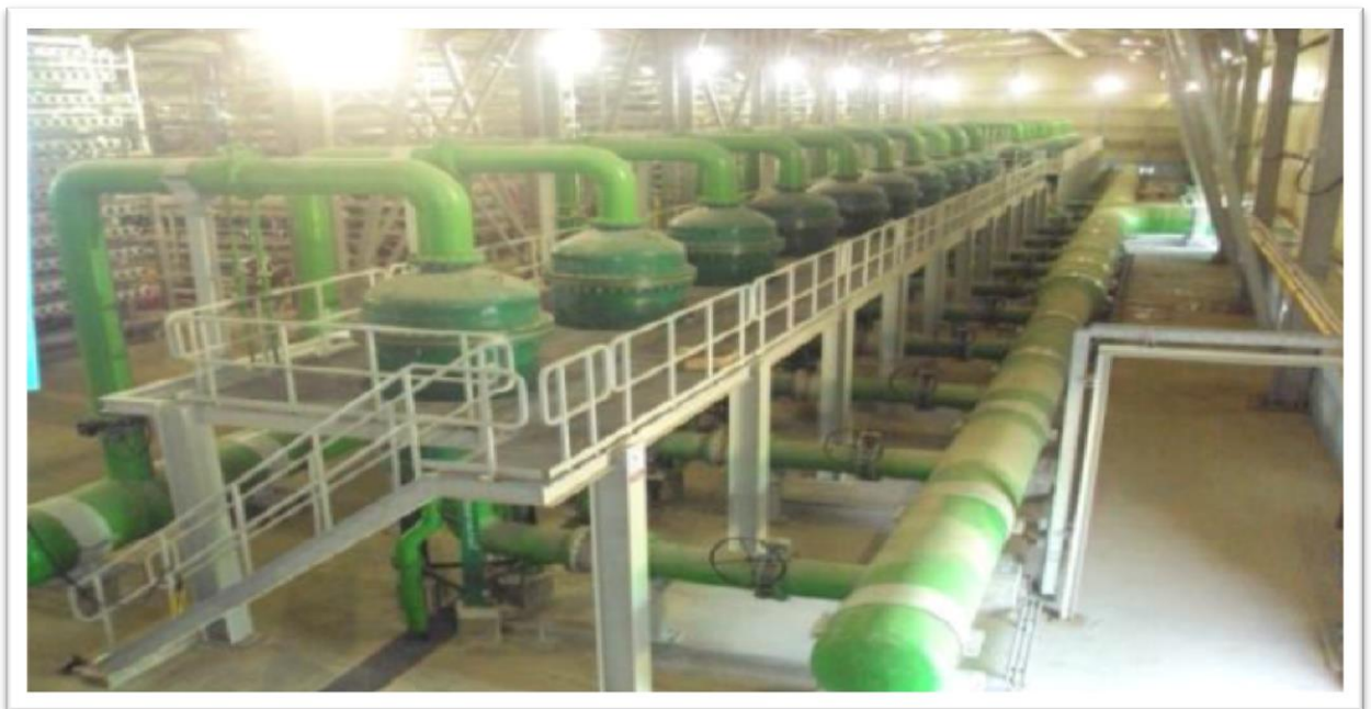
Figure IV. 17 : Filtres à cartouches [39]
