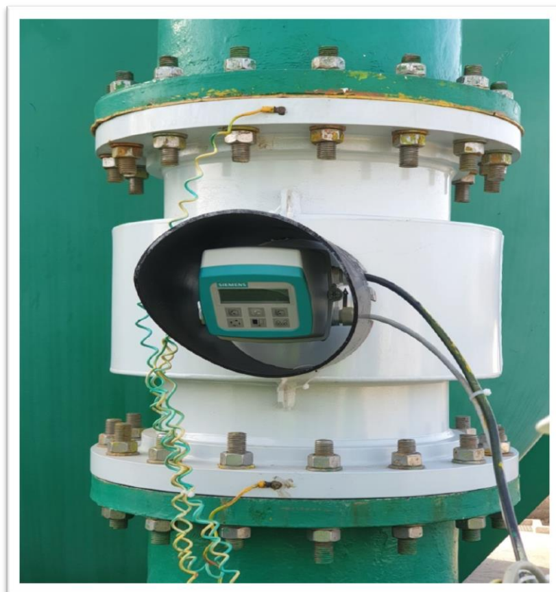
Figure IV. 14 : Débitmètre, 17 mars 2025.
