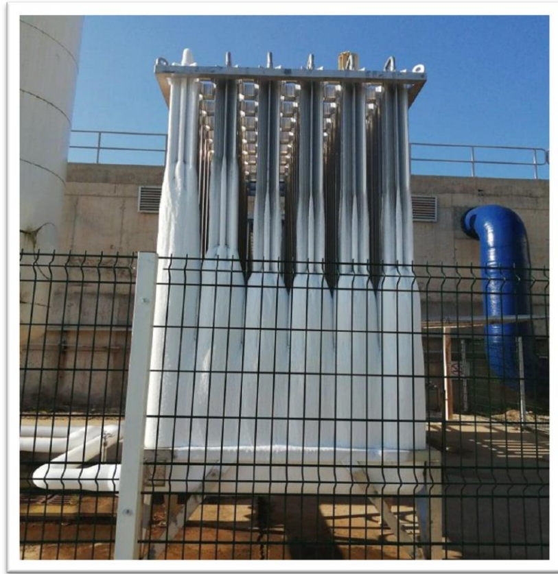
Figure IV. 26 : Evaporateur de CO 2 , 23 mars 2025.
