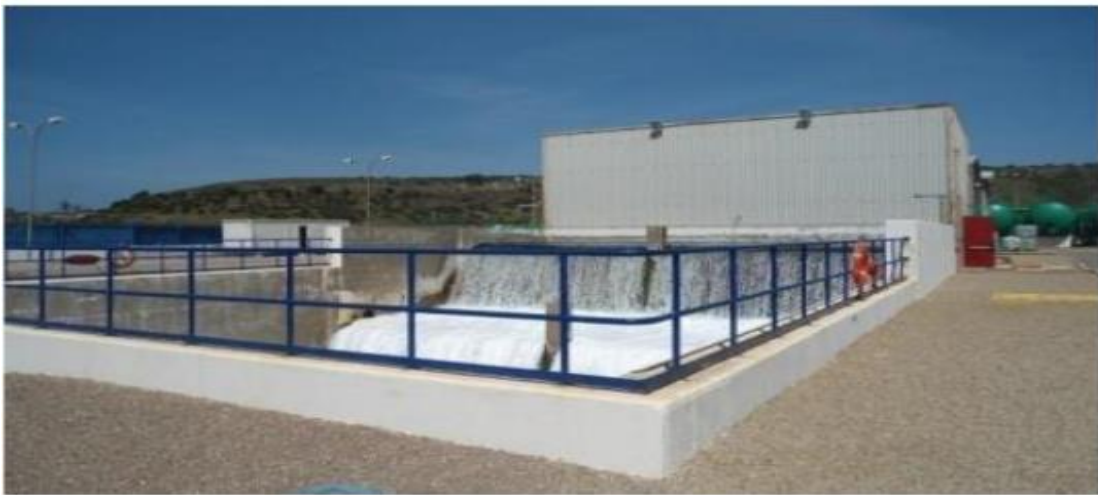
Figure IV. 28 : Bâtiment de saumure où l'eau de rejet de saumure. [39]
