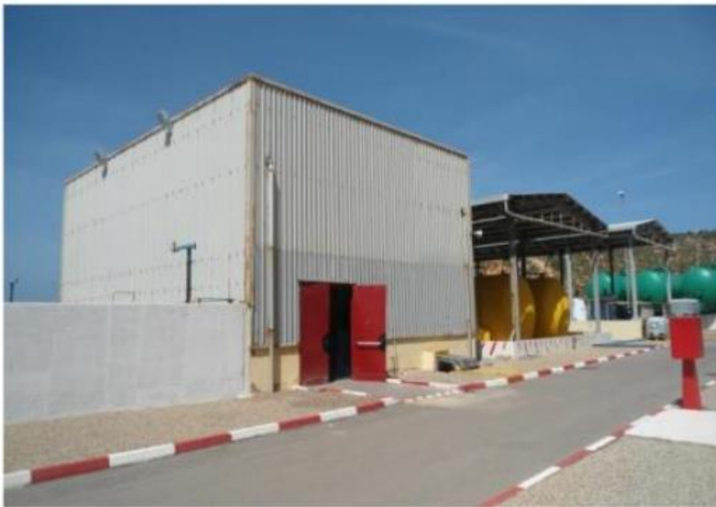
Figure IV. 27 : bâtiment de lavage des filtres. [39]
