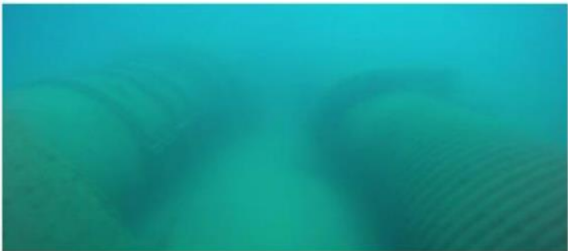
Figure IV. 5 : Les tuyaux de captage. [42]
