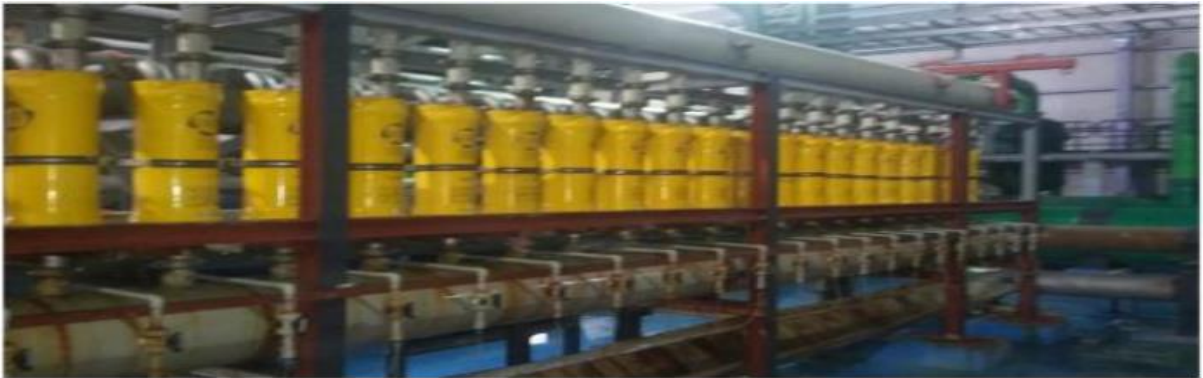
Figure IV. 22 : Chambres d'échange de pression, 16 mars 2025.
