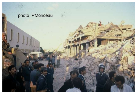
Figure 12 : Séisme de l'Asnam 1980
