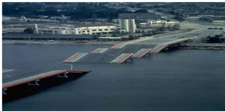
Figure 2.4 : Rupture du pont de Showa, à Niigata au Japon, dues à l'épandage latéral dans le sol (Peter M. Byrne et al, 2008.)
