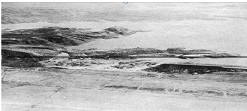
Figure 2.5 : Vue aérienne de la rupture de barrage de Fort Peck (corps de l'armée des États-Unis d'Ingénieurs, 1939, d'après Mike Jefferies et Ken Been, 2006)
