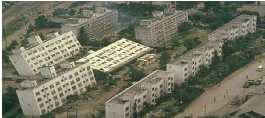
Figure 2.3 : Inclinaison des bâtiments d'appartements de Kawagishi-cho à Niigata au Japon dues à la chute de la capacité portante du sol par liquéfaction ((d'après Peter M. Byrne et al, 2008)
