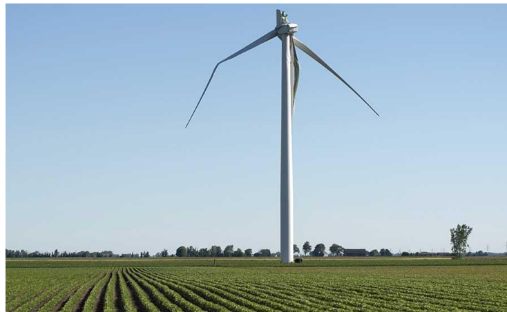
Figure I.7: Rupture par flexion dans les ailes éoliennes [10]
