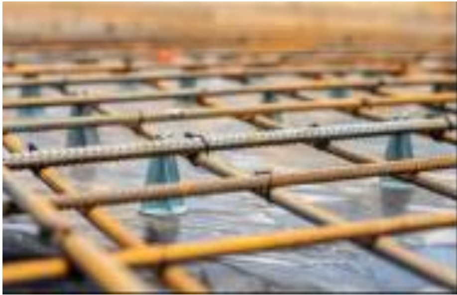
Figure 7: Système d'armature à une seule nappe
