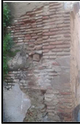
Figure 29: mur intérieur en brique de terre cuite
