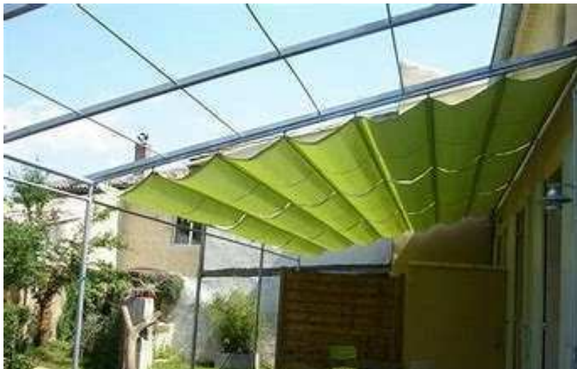
Figure 131: le toit rétractables pour les atruim des ateliers artistiques
