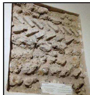
Figure 26: Mur mixte en brique et pisé
