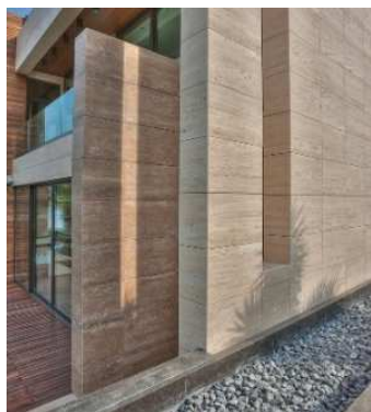
Figure 10: mur épais en pisée
