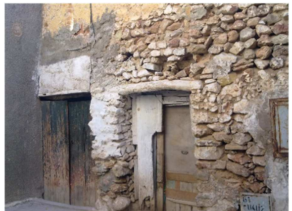
Figure 53: Appareillage d'un mur en brique et un linteau en rodin de bois d'une porte d'entrée
