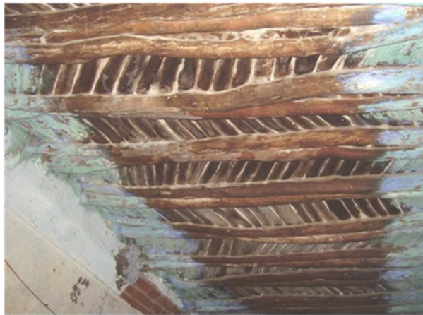
Figure 52: plancher en bois d'un bayt
