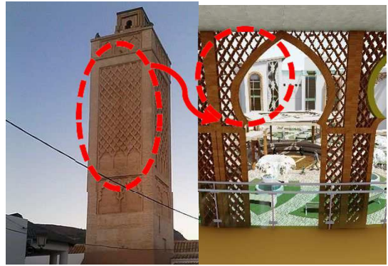
Figure 116: la façade de la grande mosquée avec le motif inspiré
