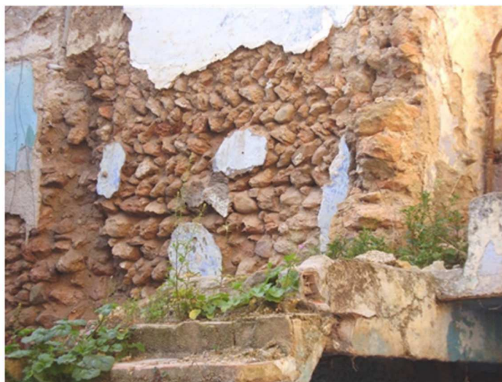
Figure 51: Un mur en moellon avec une technique de disposition rudimentaire
