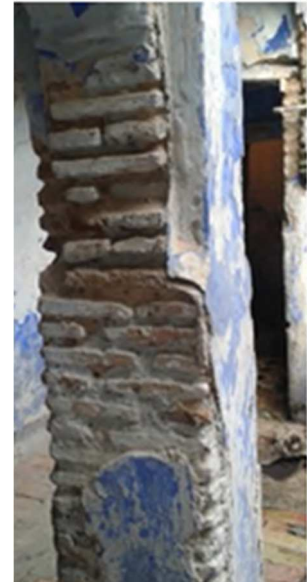
Figure 36: pilier en brique de terre Source :Magister Djilali Imane
