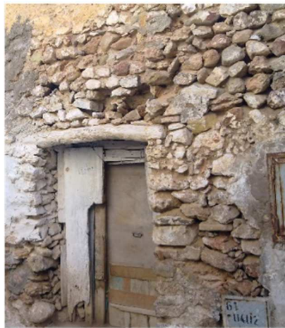
Figure 35: Linteau en bois
