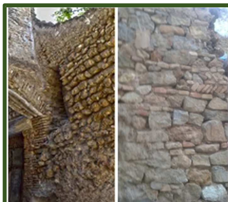
Figure 27: Mur en pierre et brique de terre cuite
