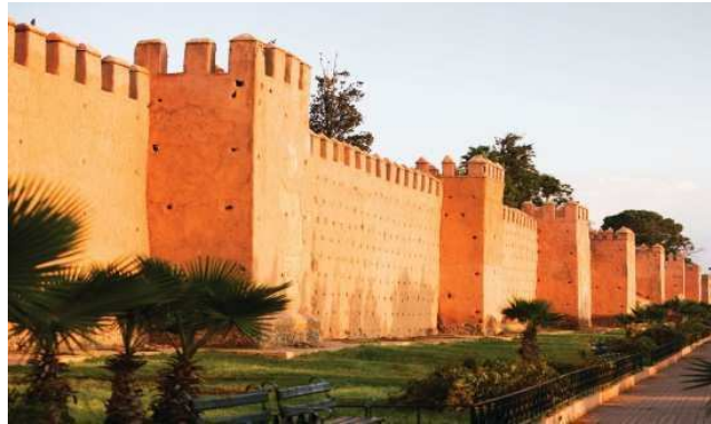
Figure 19: Les fortifications de médina de marrakech
