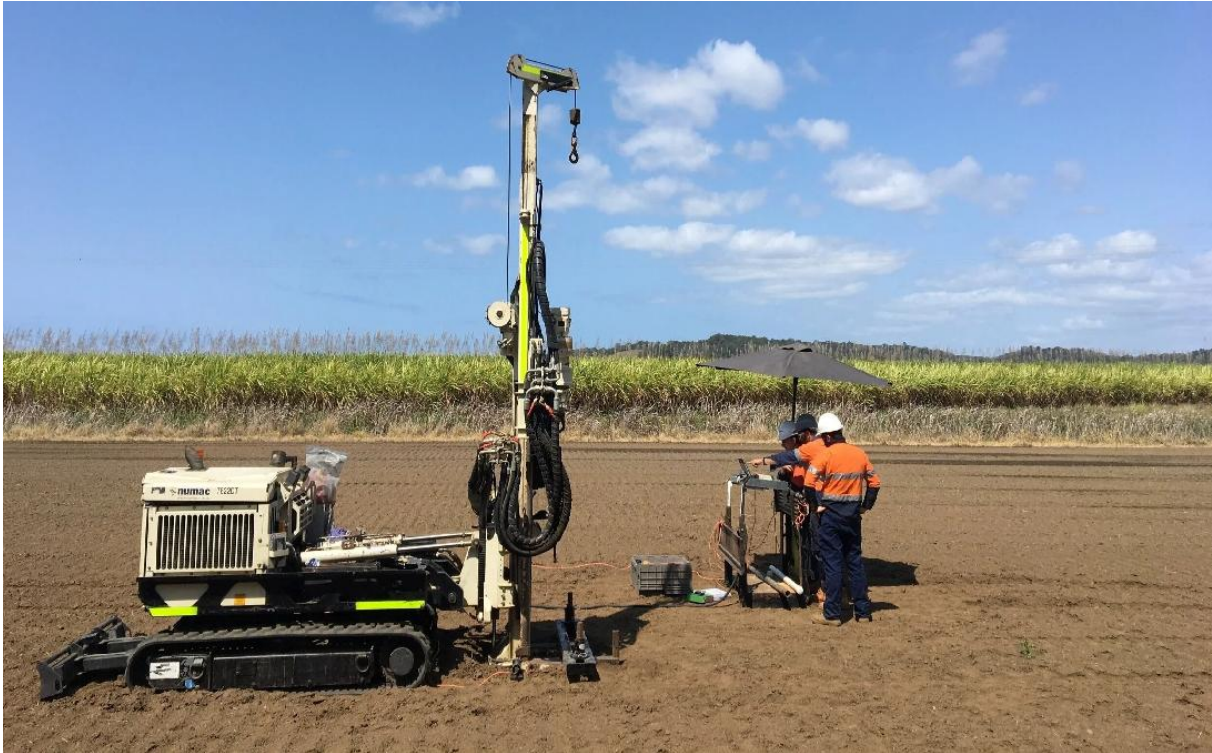
Figure I. 5 : Le test de pénétration au cône (CPT)
