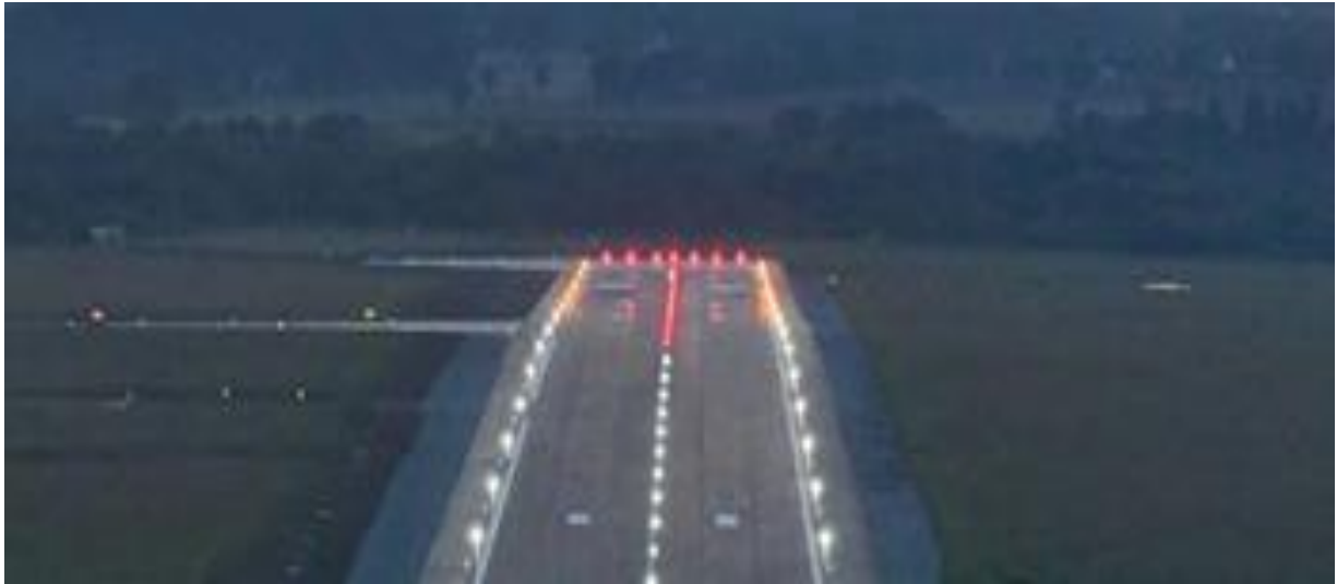
Figure 34- Balisage de l'extrémité de piste [avionnaire]
