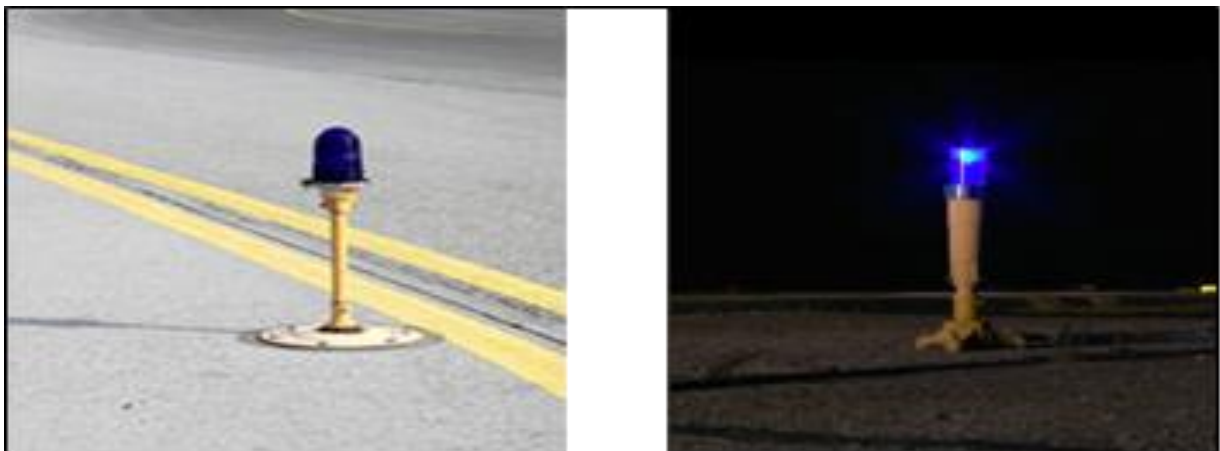
Figure 38- Balisage voies de circulation [Avionnaire]
