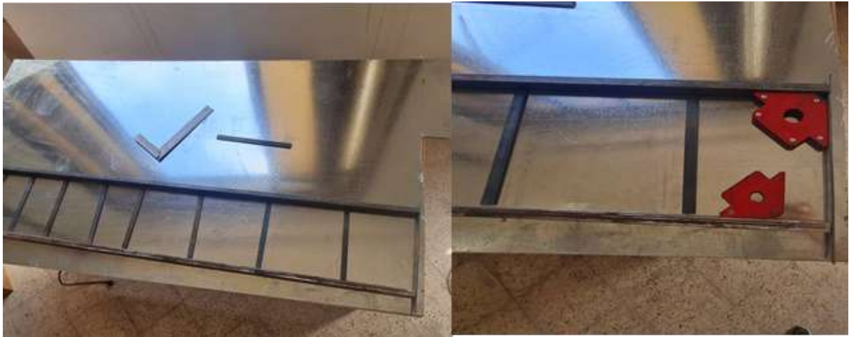
Fig III.4. Préparation des moules pour le coulage.
