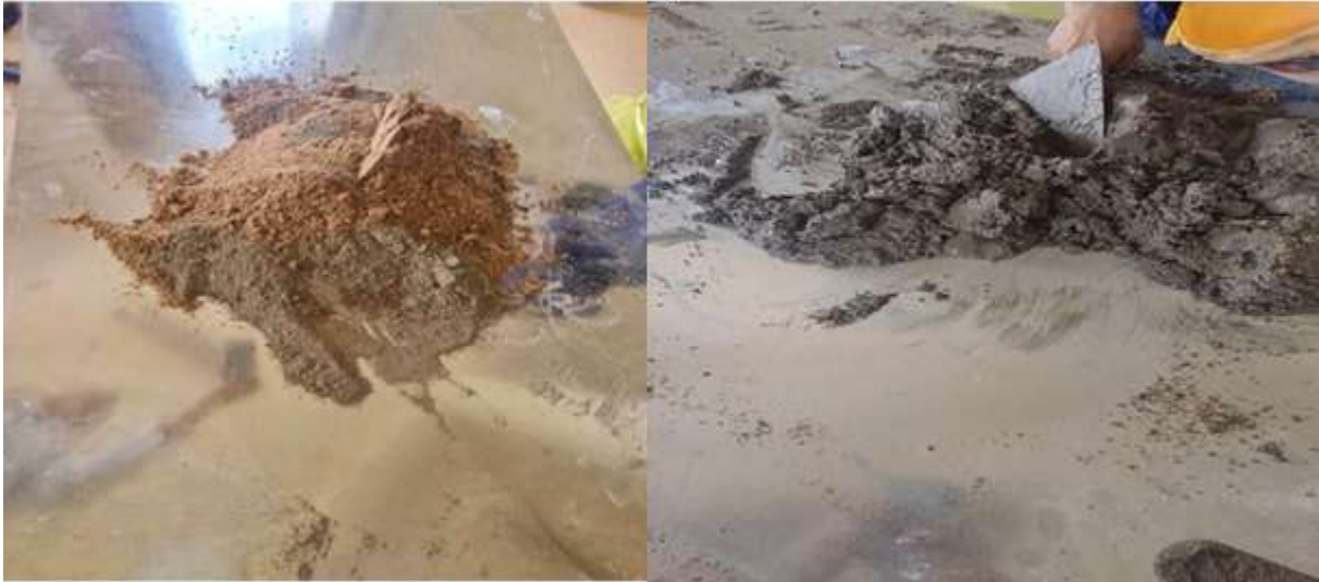
Fig.III.8. Préparation du mortier
