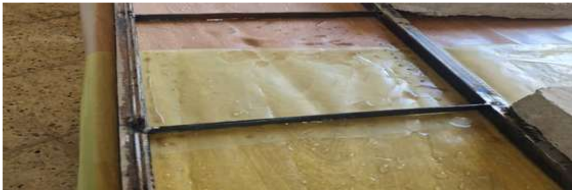
Fig.III.9 Application de gouttes d'eau sur la feuille de plastique.
