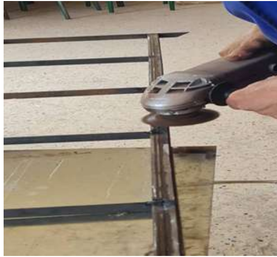
Fig III.6. Ponçage final du moule.
