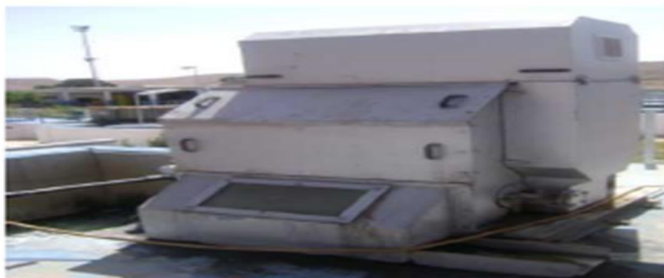
Figure III-05 : Le tamis rotatif (Manuel de la station 2006).
