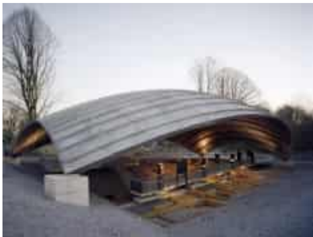
Figure 83: la couverture des fouilles archéologiques
