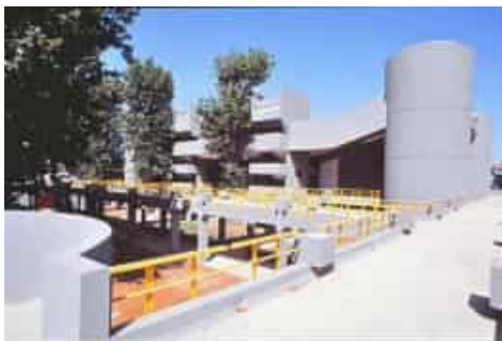
Figure 87: l'état initial de la maison de la culture
