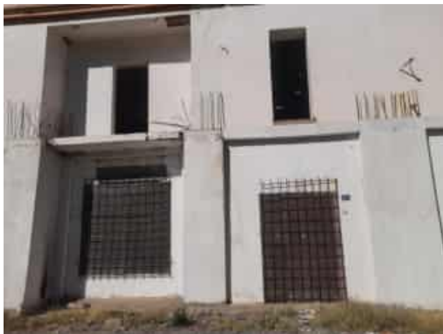
Figure 62: l'état actuel d'ancien hotel
