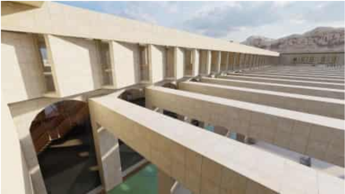
Figure 110:les baies inclinées de la façade
