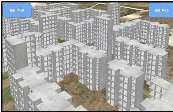
Figure 12 : construction des logements . Source : https://www.radioalgerie.dz/news/fr/tags/relogement?page=3
