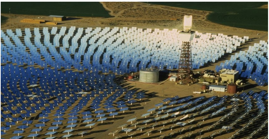
Figure I. 2:Présentation de centrale solaire thermodynamique à concentration
