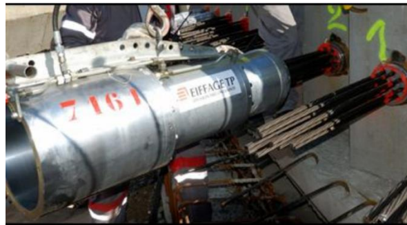
Figure IV.2 dispositif de précontrainte [19]
