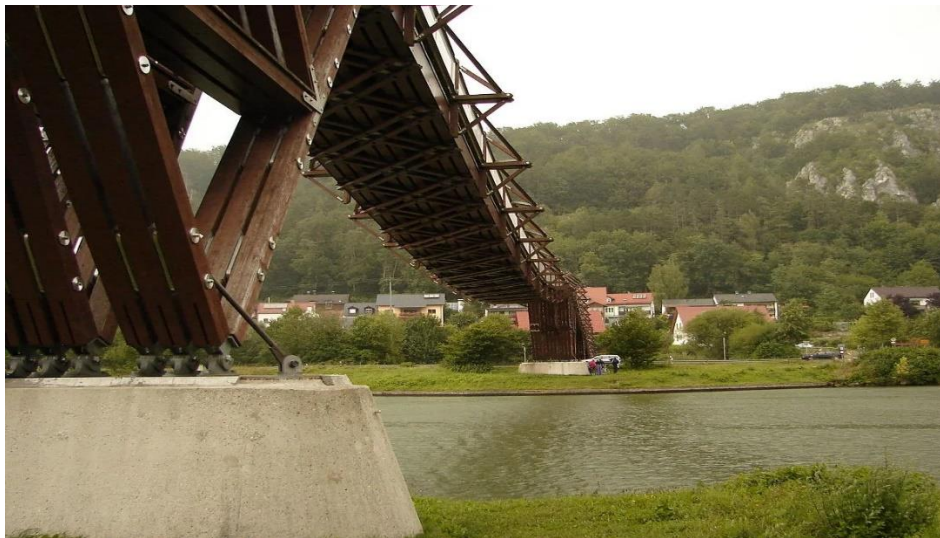
Figure I.2 Pont d'Essing en Allemagne [3]
