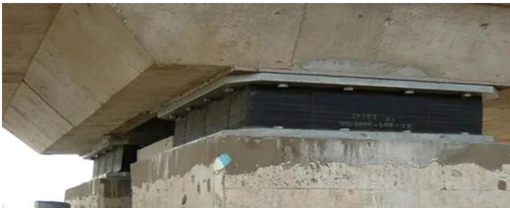
Figure IX.1 appareil d'appui en élastomère fretté
