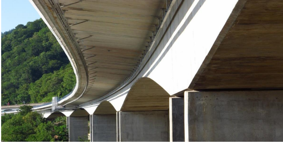
Figure I.5 Viaduc de Chillon (Suisse) [6]
