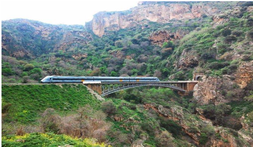
Figure I.4 Pont Eiffel les cascades d'El Ourit (Tlemcen) [5]
