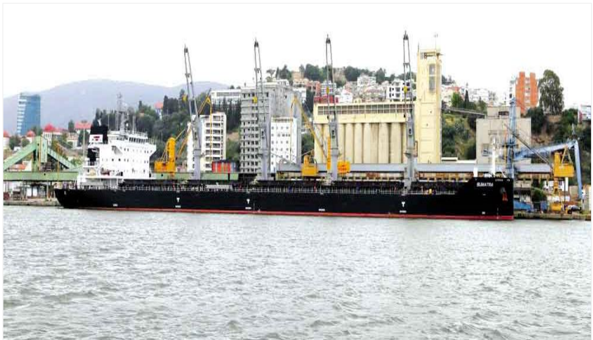
Figure 1.11 Rénovation de quais et acquisition d'équipements au port d'Annaba (Algérie)
