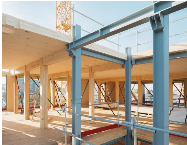
Figure 1.6 Construction d'un bâtiment en matériau mixtes
