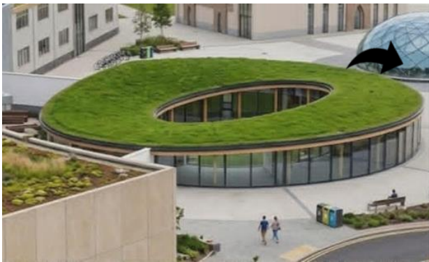
Figure139: Toiture école maternelle (par auteurs)
