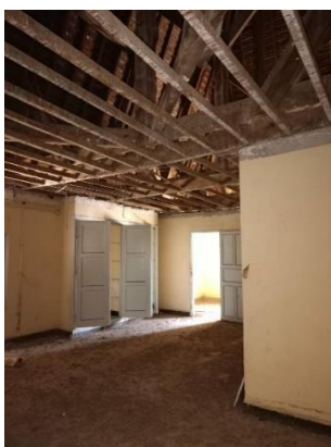
Figure127: les profiles métalliques au niveau de la dale du chateau (auteurs 08/10/2025)
