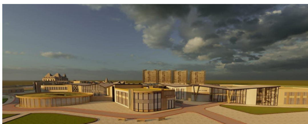
Figure124 :façade urbaine Est (par auteurs)
