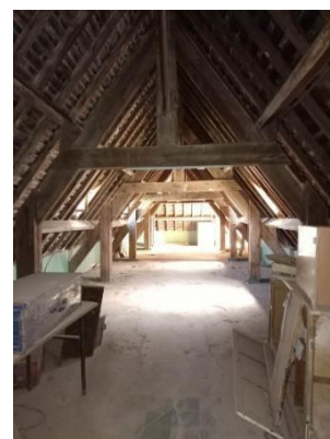
Figure128: la charpente en bois de l'intérieur du chateau ( auteur 08/10/2025)
