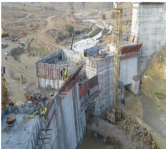
Photo 5 : Vue du barrage d'Oued Taht bétonnage du couronnement.
