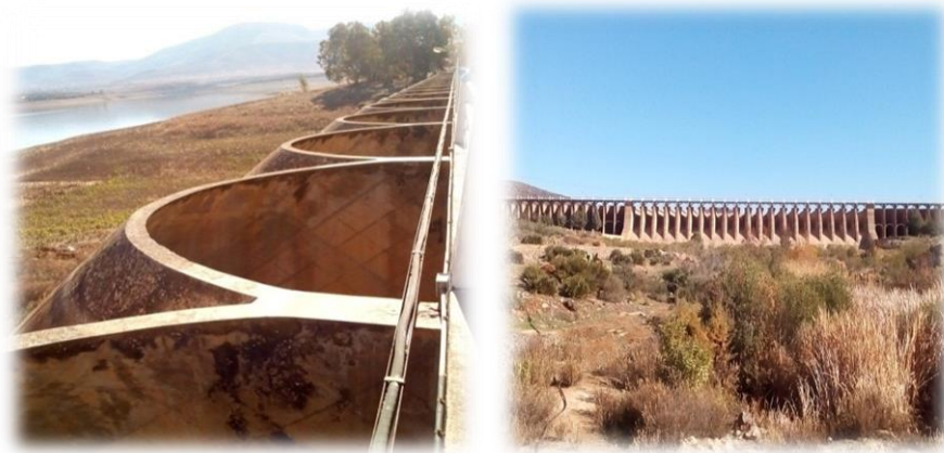
Photo 1: Barrage à voûtes multiples de Beni Bahdel (Algérie).
