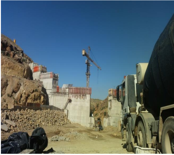
Photo 3 : Vue aval du barrage d'Oued Taht bétonnage du plot central.
