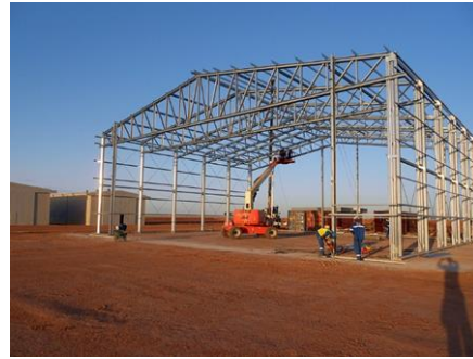
Figure 9. Montage lourde d'une charpente métallique.
