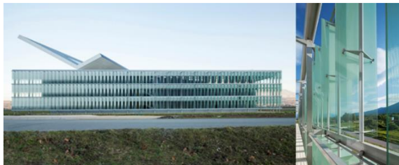
Figure 123. Façade mobil par lames de verre orientables.
