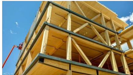
Figure 87. Structure mixte combine l'acier et le bois lamellé collé.
