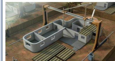
Figure 2. Impression 3D d'un logement.
