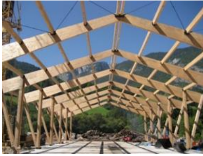
Figure 77. Ossature portique lamellé collé.
