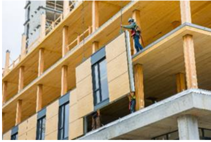
Figure 10. Installation légère des panneaux de façade.
