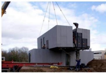
Figure 94. Modules en béton.
