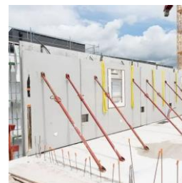
Figure 93. Panneaux en béton.
