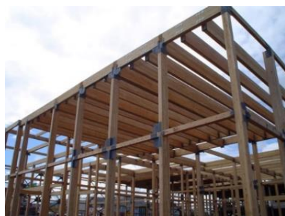
Figure 75. Ossature poteau-poutre lamellé collé.
