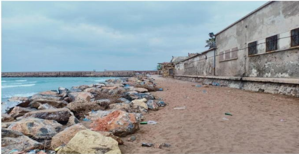
Figure27 :la plage du puits(partieEst), (Diboun,2020)
