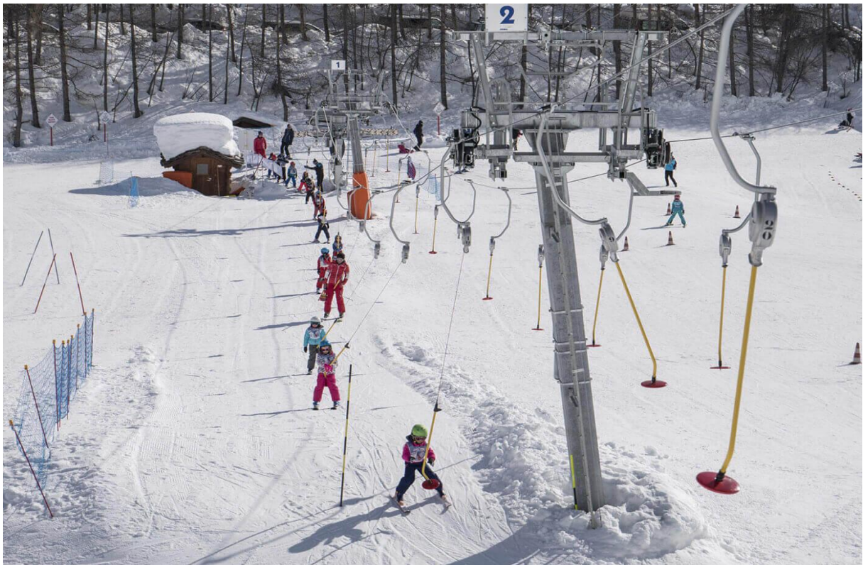
Figure 7 Télésiège à archets [9]
