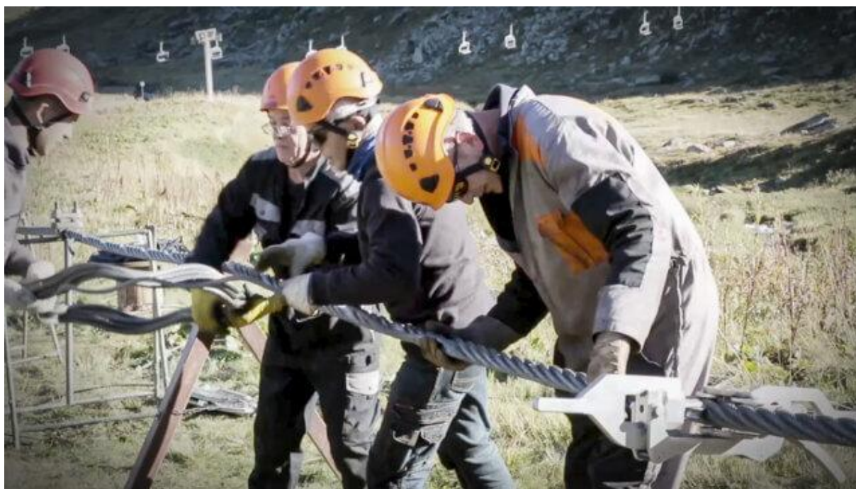
Figure 50 Réalisation d'une épissure de câble d'une remontée mécanique [20]
