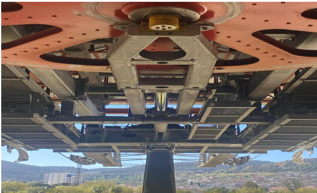
Figure 37 Accouplement du lorry avec système de tension [Photo personnelle]
