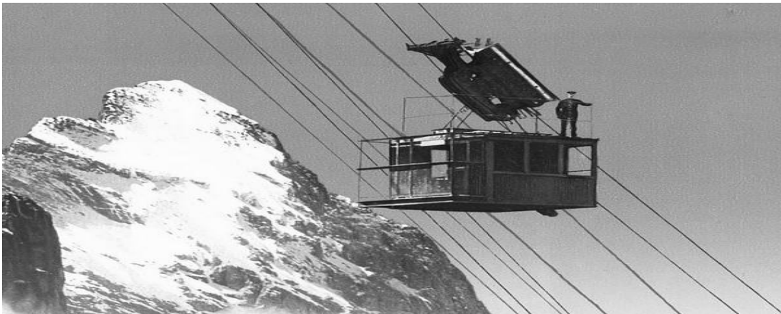
Figure 11 Téléphérique du Wetterhorn, Grindelwald, Suisse [9]
