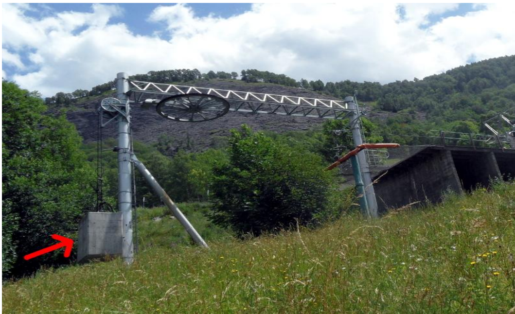
Figure 35 Un contrepoids de tension du câble en action [31]
