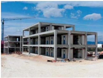
Figure 72 : portique en béton
