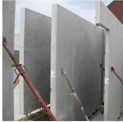
Figure 77 : Murs en béton préfabriqués
