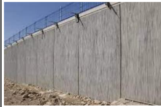
Figure 23 : Mur de soutènement
