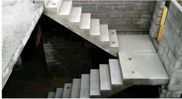
Figure 79 : Les cages d'escaliers préfabriqués
