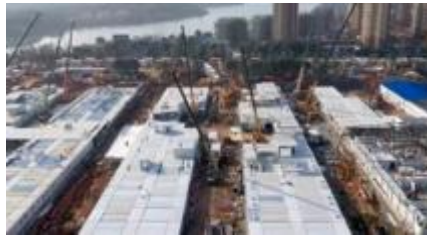
Figure 14 : L'hôpital préfabriqué à Wuhan, Chine
