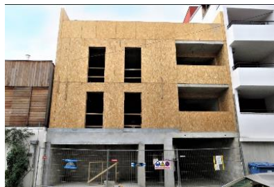
Figure 18 : immeuble R+3 en panneaux massifs
