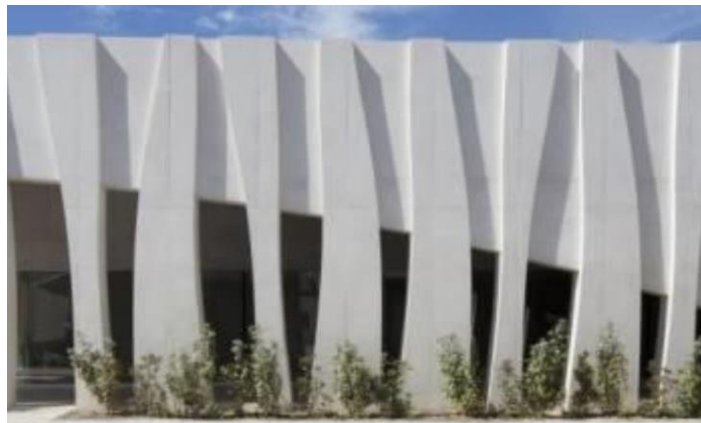
Figure 32 : façade avec des des éléments de modénature préfabriqué
