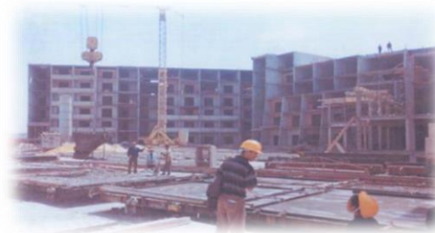
Figure 7 : Atelier précaire à l'air libre au pied de l'ouvrage à édifier.
