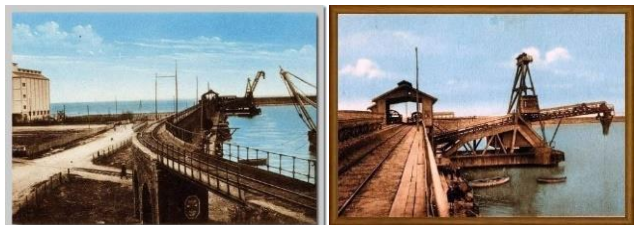
Figure 46 et 47: Ligne pour le transfert de mines vers le port.
