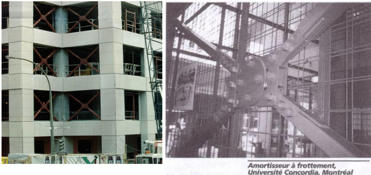
Figure II.11. Amortisseur à frottement à l'université de Concordia, Montréal
