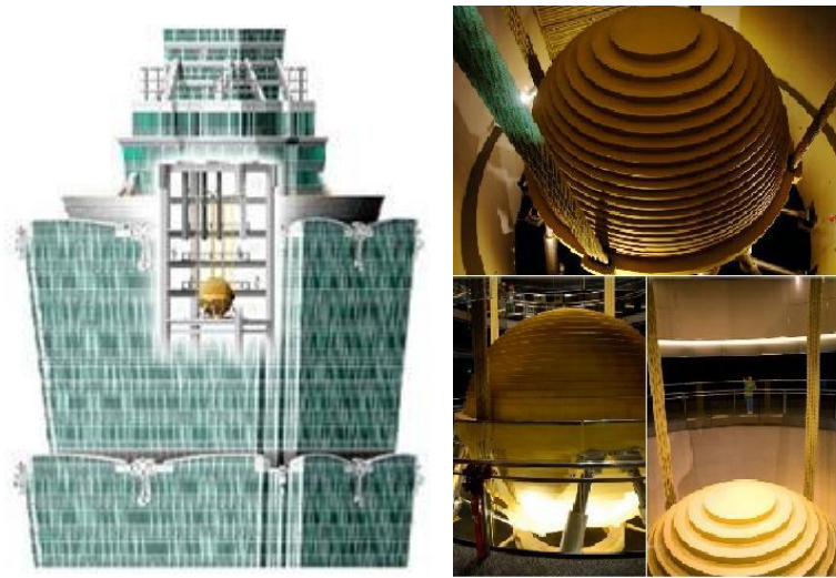
Figure II.12. Un TMD pendulaire de 800 tonnes dans un bâtiment de 508 m de hauteur (tour de Taipei 101)
