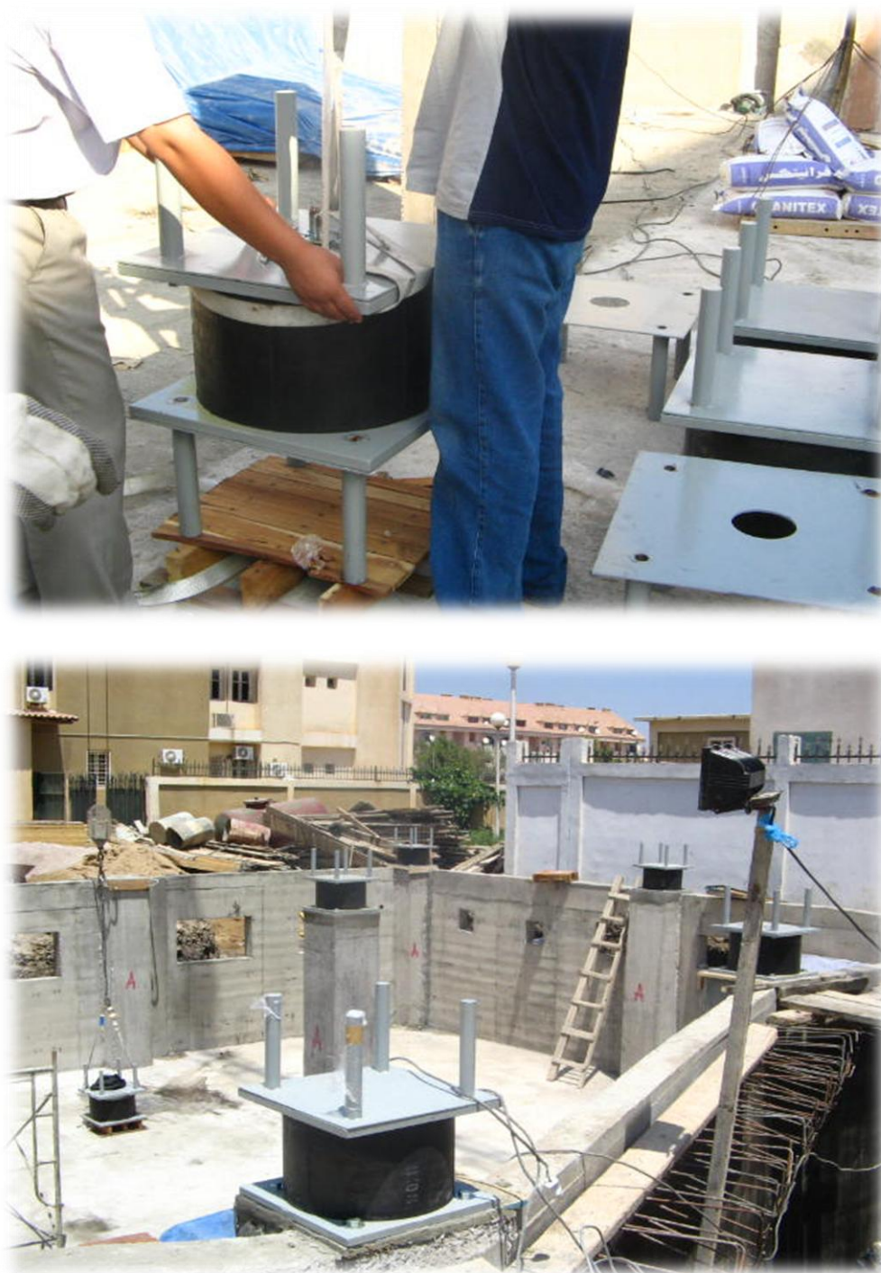
Figure I.12. Installation des dispositifs parasismiques [11]
