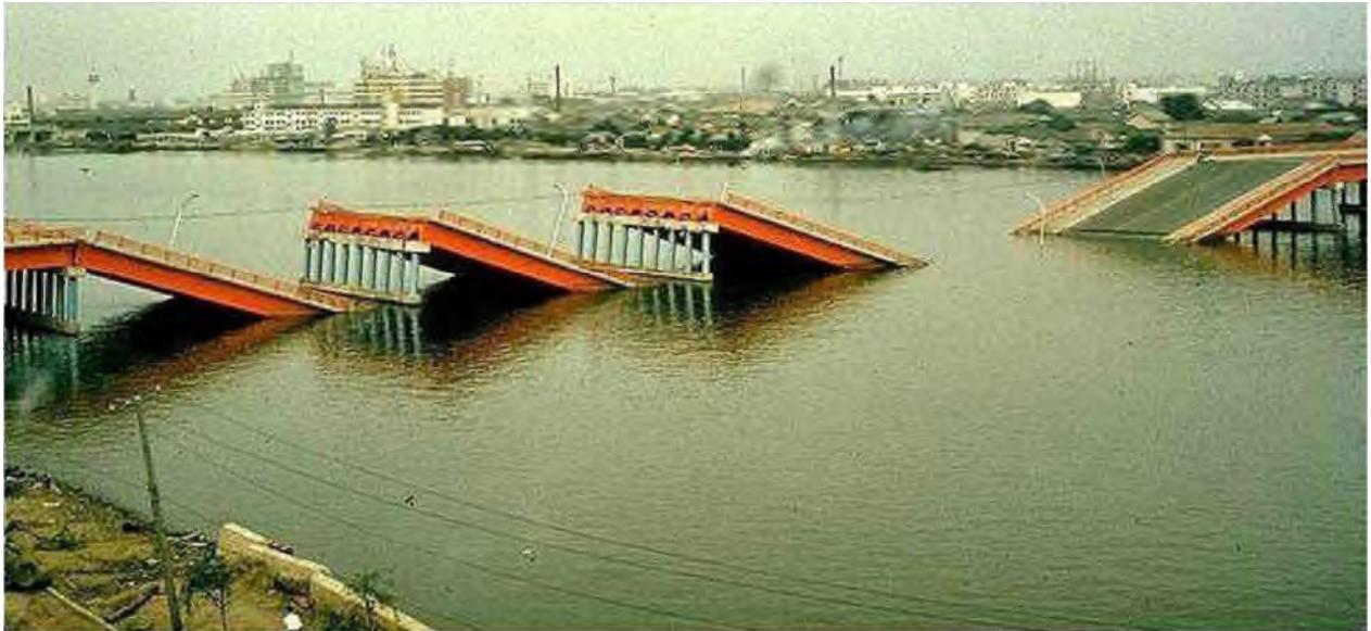
**Figure I.3.** Délogement des travées du pont de Showa suite au séisme Niigata [3]
