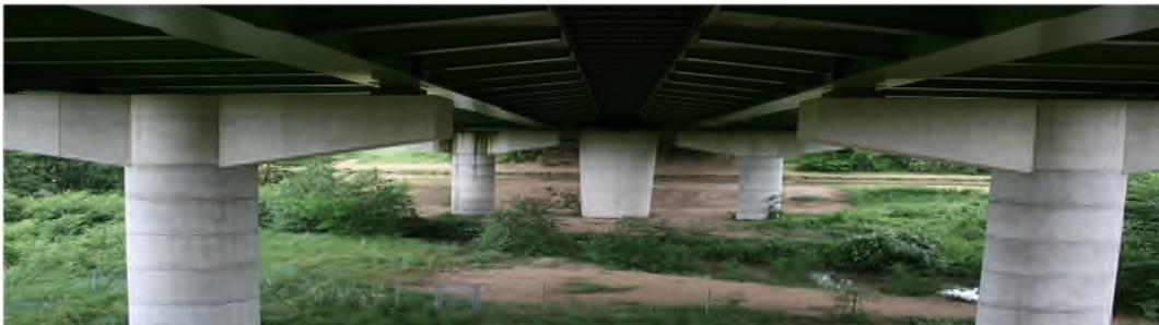
Figure I.10. Photo des piles marteaux [3]
