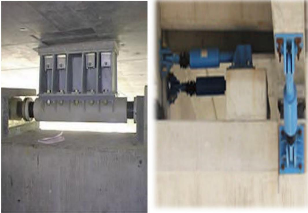
**Figure II.9.** Photo d'un amortisseur visqueux [12].
