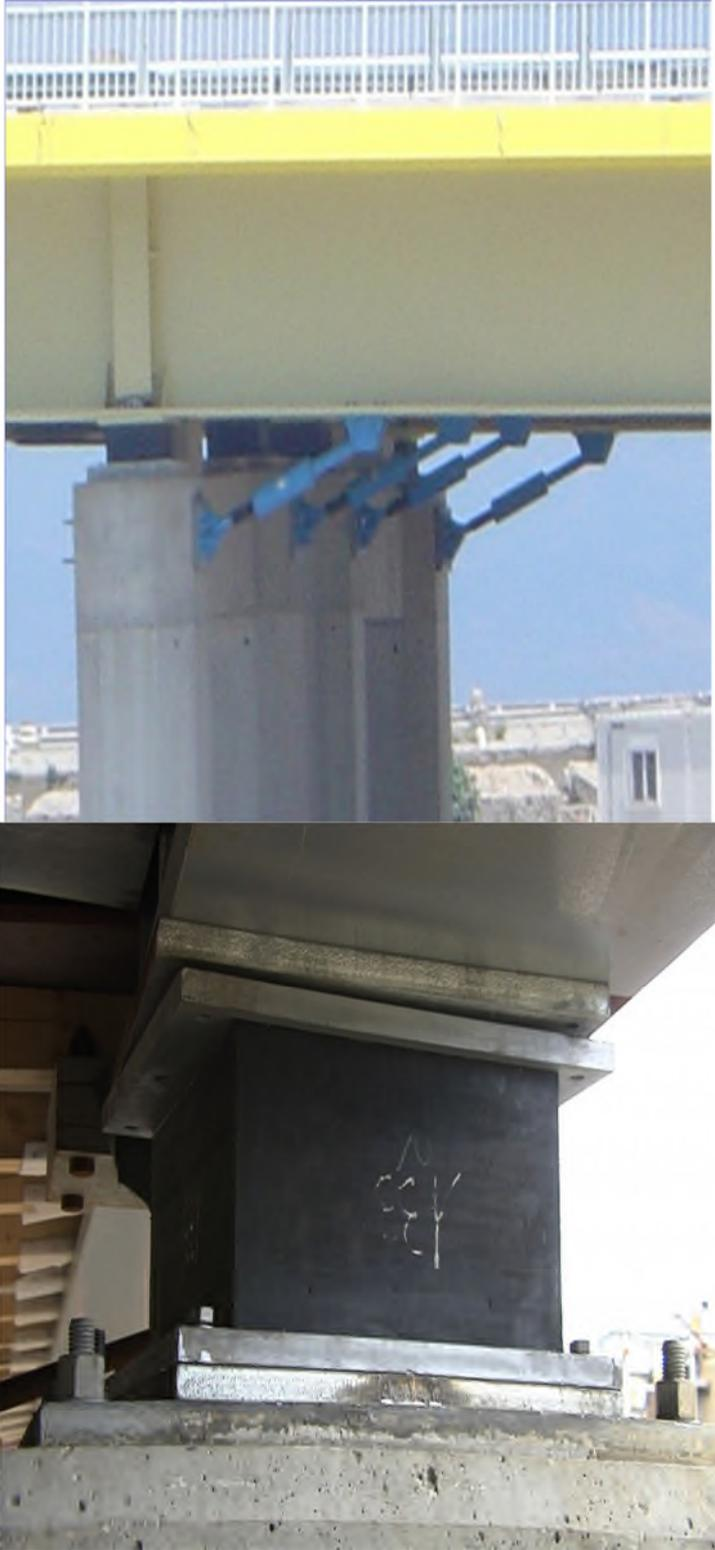
Figure I.11. Photo représente la localisation des isolateurs parasismiques pour les ponts [17].
