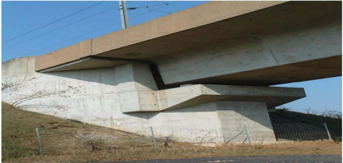
**Figure I.5.**Photo d'une culée d'un pont [8]
