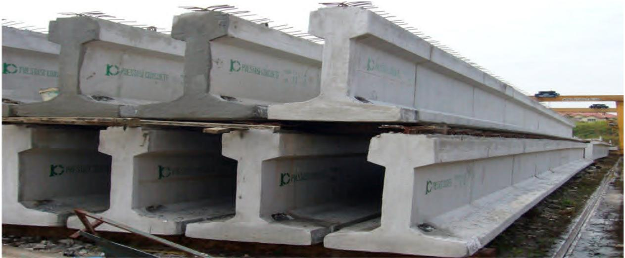
Figure I.7. Photo des poutres précontraintes [9]
