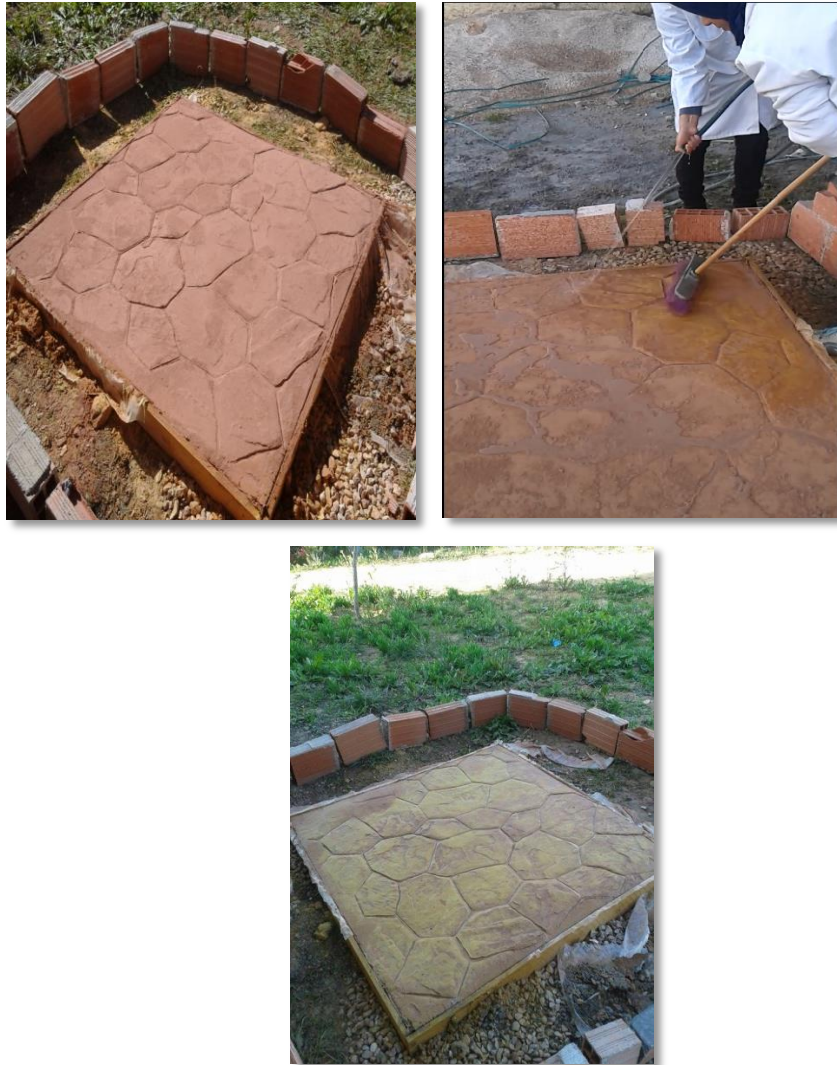
Figure 1. 9. Lavage à l'eau de la surface (photos prises par les auteurs)
