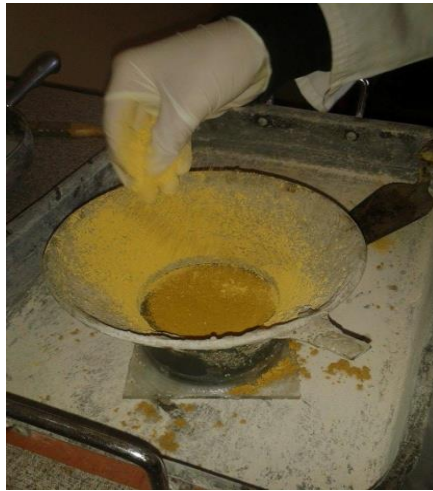
Figure 3. 7. Saupoudrage de durcisseur sur la surface du MT (Photo prise par les auteurs)
