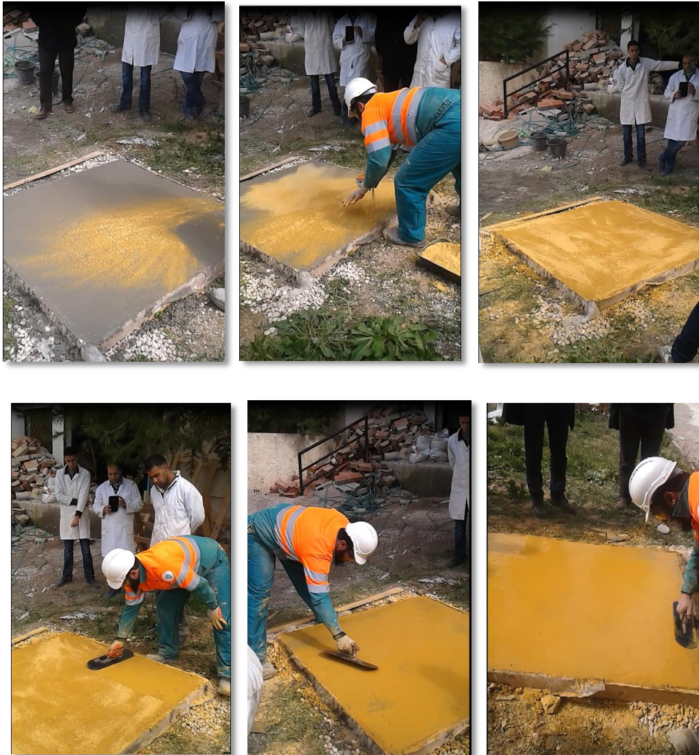
Figure 1. 5. Epannage et lissage du colorant en surface (photos prises par les auteurs)
