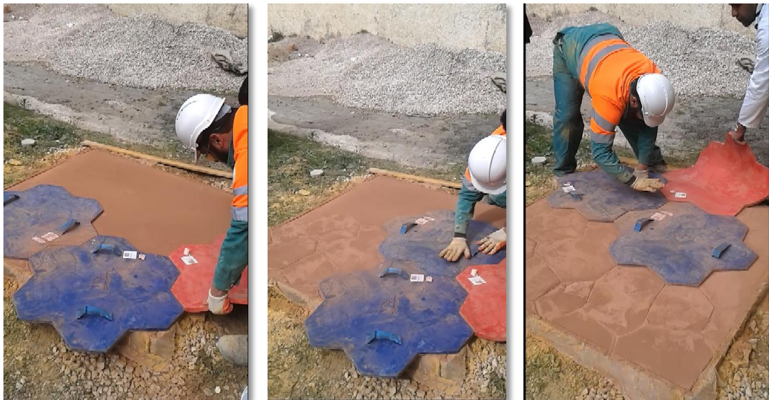
Figure 1. 8. Impression des motifs en surface à l'aide de moules (photos prises par les auteurs)
