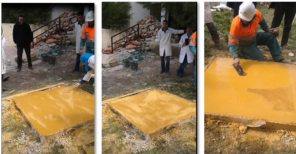
Figure 1. 6. Opération de relissage du colorant en surface (photos prises par les auteurs)
