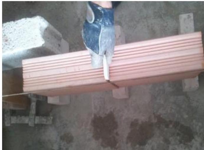
**Figure 3.16 :** Respecter l'épaisseur des joints des murets (photo prise par les auteurs)
