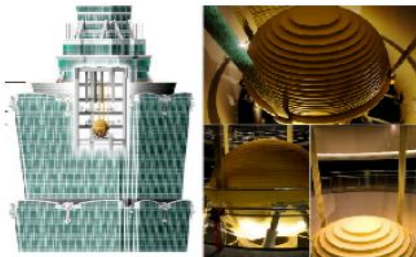
Figure 1. 15: TMD pendulaire de la tour de Taipei (Taybi, 2013).
