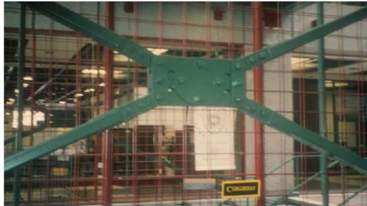
Figure 1. 5: Amortisseurs à frottement (Bentifour, 2013).
