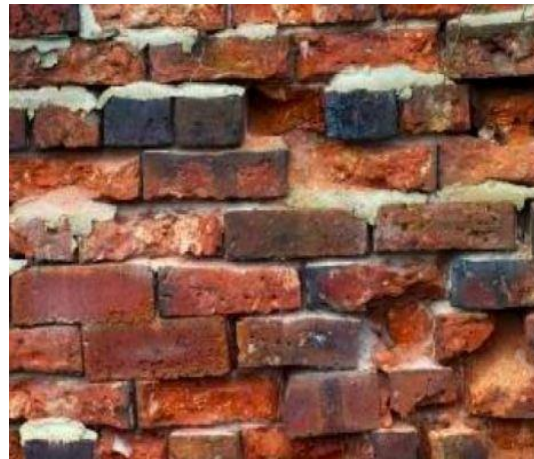
(b)- dislocation et émiettement de la brique.
