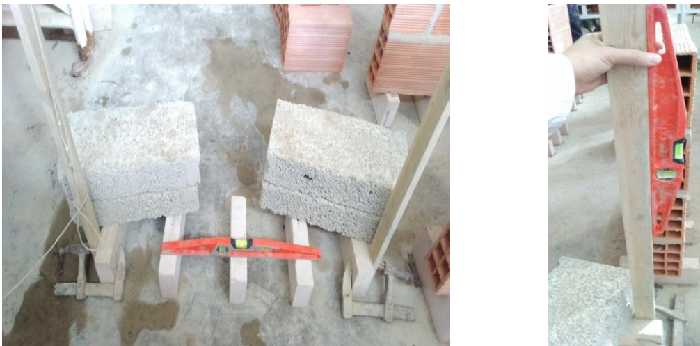
Figure 3.28 : Dispositif de l'essai pour la confection des murets (photos prises par les auteurs).
