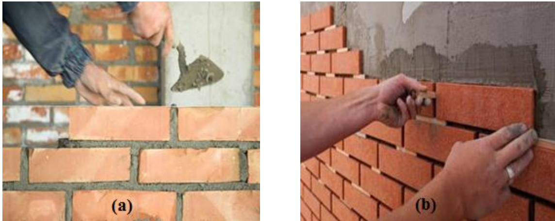
Figure 1.1 : Maçonnerie en brique pleine.
