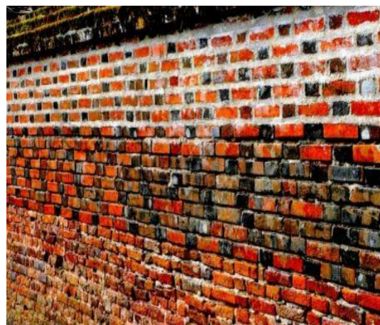
(d)- Nettoyage par micro-sablage et hydro-gommage.
