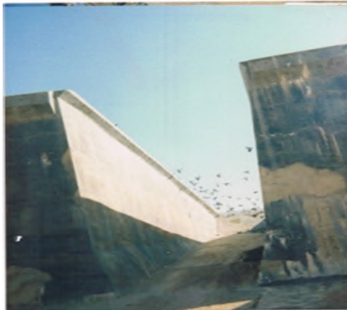
Photo III.6 : Vue sur la cuvette d'un bec (Barrage BAKHADDA).
