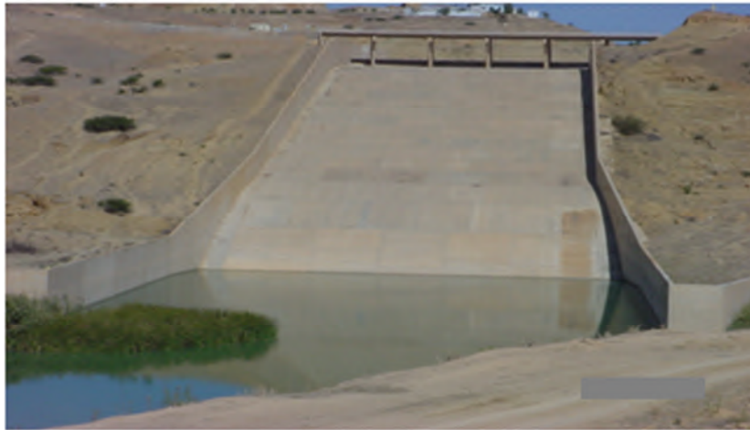
Photo III.4 : Evacuateur de crue de barrage Sidi-Abdelli [31].
