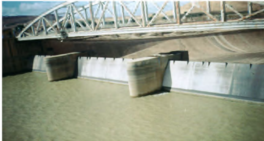
Photo I.9 : Barrage Bou-Hanifia à déversoir de superficie à seuil mobile [5].
