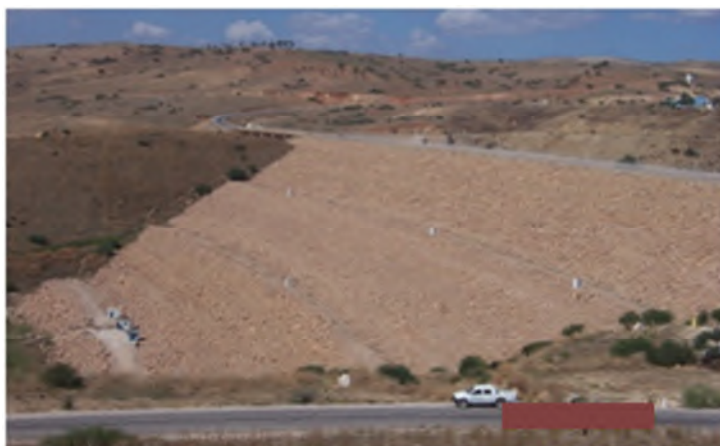
Photo III.1 : Digue du barrage Al Izdihar Sidi-Abdelli [31].
