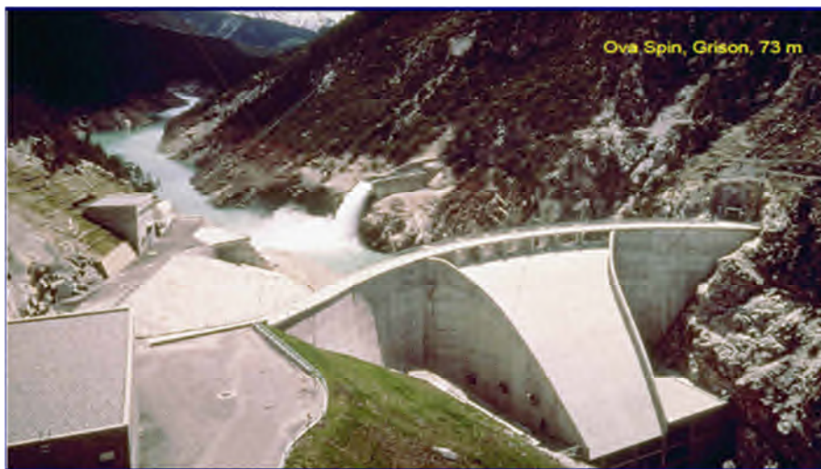
Photo 1.2 : Evacuateur porté par le barrage Grison.
