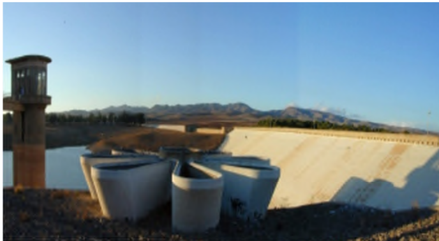
Photo I.7 : Evacuateur en puits marguerite [4].
