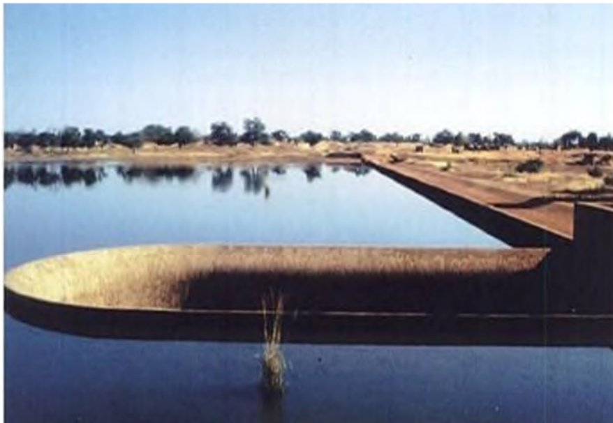
Photo I.13 : Déversoir « bec de canard » du barrage de Lumbilia (Burkina Faso) [10].
