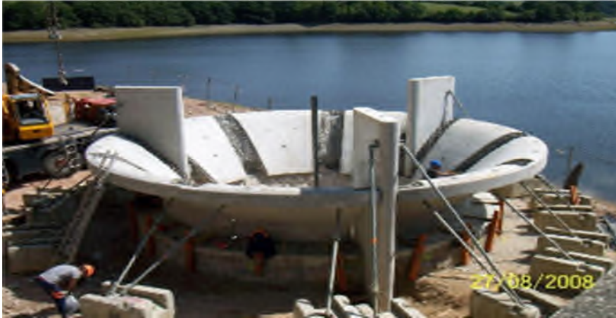
Photo I.6 : Evacuateur en puits circulaire.
