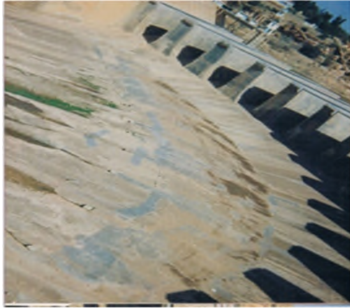
Photo III.7: Vue d'aval sur les becs avec zone du Creager (Barrage BAKHADDA).
