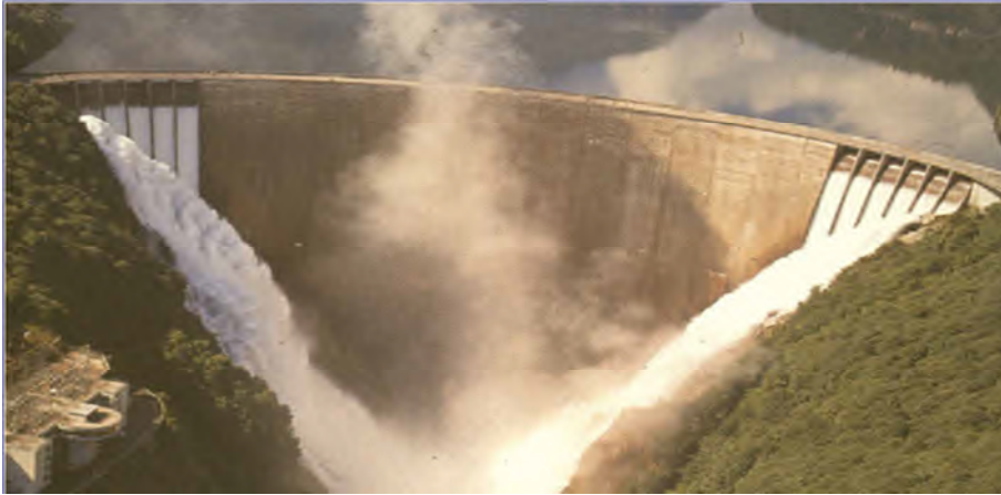
Photo I.3 : Evacuateur porté implanté sur les rives du barrage.
