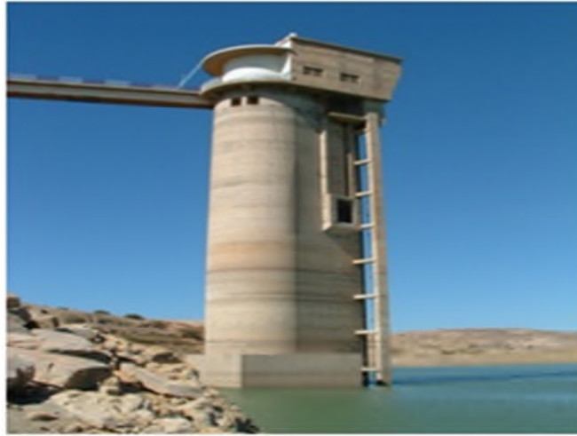
Photo III.2 : Tour de prise d'eau de barrage Sidi-Abdelli [31].
