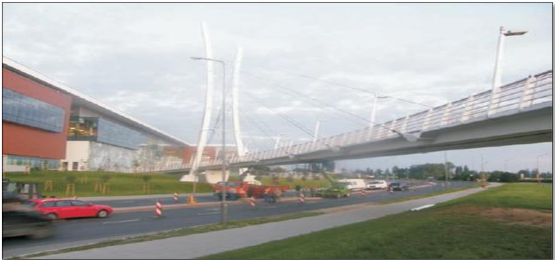
Figure 2.2 : Vue de la passerelle Malta à Poznan. (Biliszuk et al., 2003).
