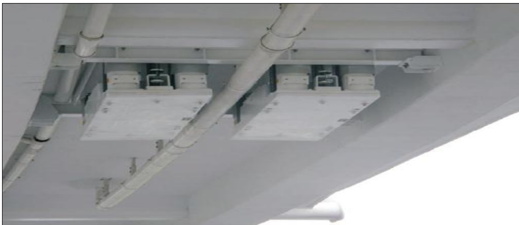
Figure 2.4 : TMD du pont au centre de Malte à Poznan. (Biliczuk et al ., 2003).
