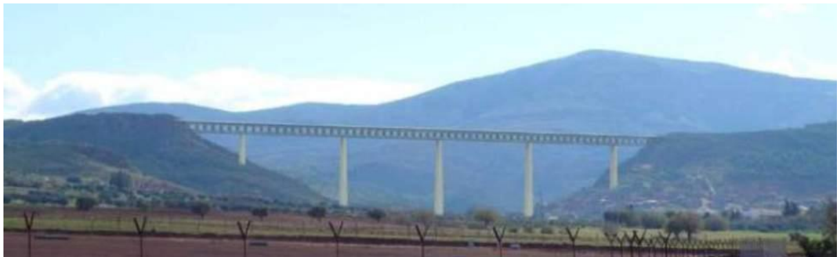
Figure 1.7a : Viaduc à tablier mixte avec poutres en treillis à Oued Isser, Tlemcen, Algérie (Condotte 2015).
