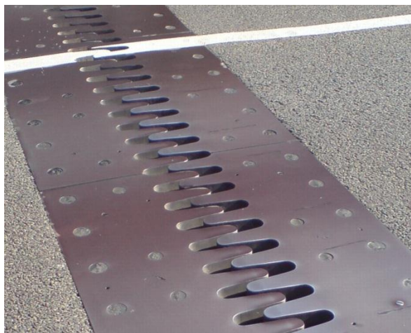
Figure 4.5. Joint à peigne à dents arrondis
