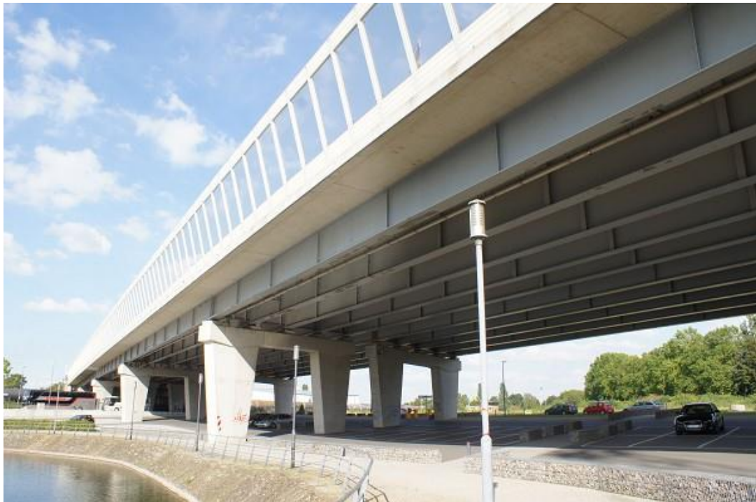
Figure 1.2 : Vue d'un pont mixte acier-béton (autoroute A59, Allemagne)
