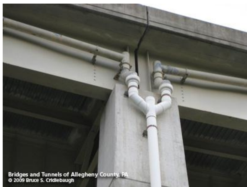
Figure 5.5. Système d'évacuation des eaux sur un pont.
