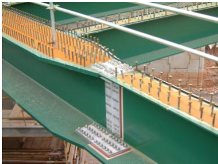
Figure 1-9 : Connecteurs de type goujons
