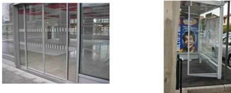
Figure (2.9) : Il n'est pas souhaitable que les feuilles de verre utilisées pour les portes de bâtiments avec accès au public et le mobilier urbain soient traitées anti-réfléchissantes. Au contraire, ces feuilles comportent des sérigraphies afin d'être visibles (ETIENNE, 2009).
