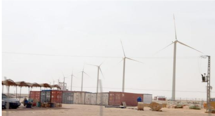
Figure 1.12 : Ferme éolienne Adrar, Algérie
