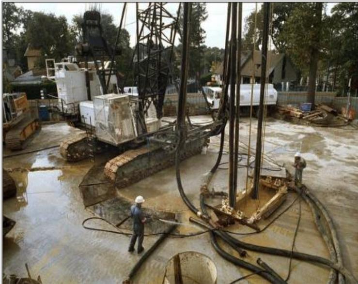
**Fig. 1.3** Creusement de parois moulées avant l'excavation du puits de la Place Berthet sur le chantier de l'A86 (Doc. Socatop 2001)
