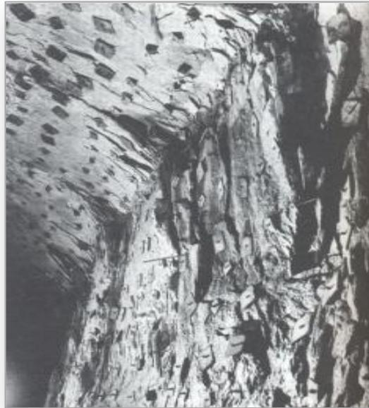
**Fig. 1. 2** Ecaillage des parois du tunnel du Mont-Blanc lors de sa construction. Remarquer la forte densité de boulonnage (CETU, 2012)
