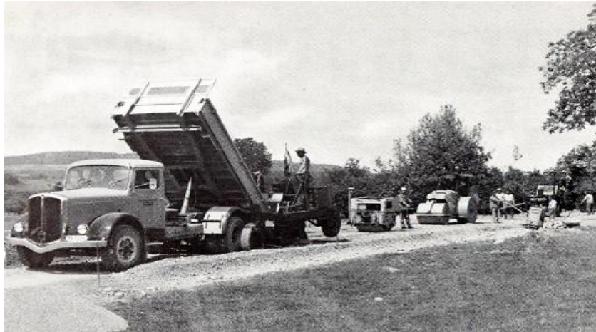
Photo 5.1 : Construction d'un chemin avec matériaux stabilisé Selon le procédé mix in plant.
