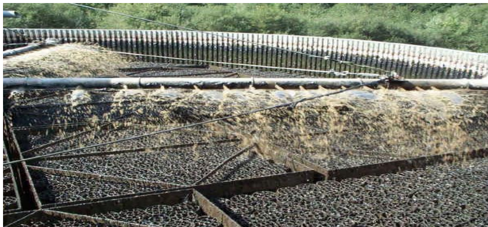
Figure II.3 : Alimentation du lit bactérien (garnissage plastique) [66].
