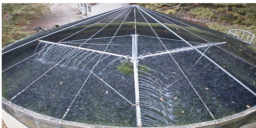
Figure II. 2 : Lit bactérien avec garnissage traditionnel [66].
