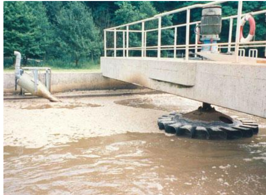
Figure II.5 : Turbine d'aérateurs de surface. [25]
