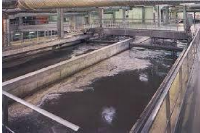
Figure II.3 : Un bassin de dessablage-déshuilage rectangulaire. [22]
