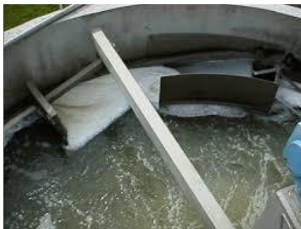
Figure II.4 : Un bassin de dessablage-déshuilage circulaire. [24]
