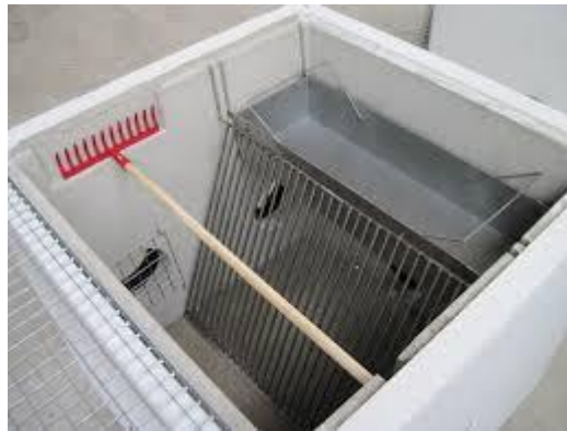
Figure II.1 : Un dégrilleur manuel avec un râteau. [14]
