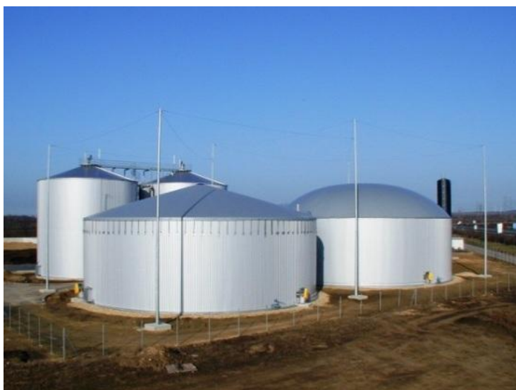
Figure II.8 : Un digesteur. [28]
