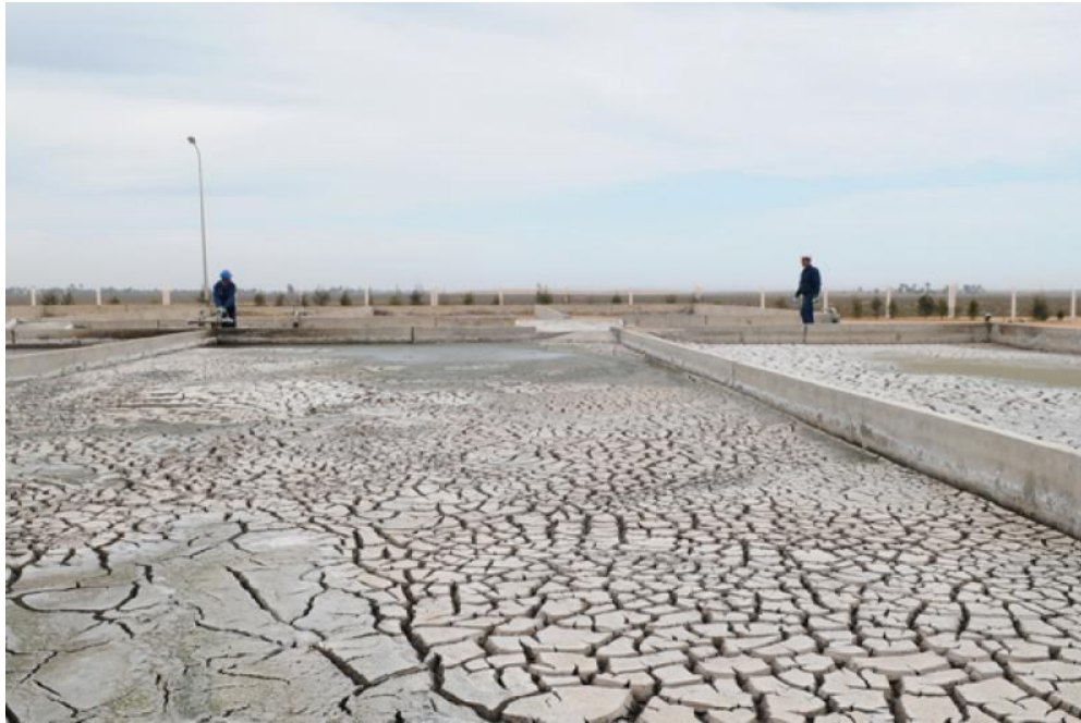
Figure II.9 : Un lit de séchage. [29]
