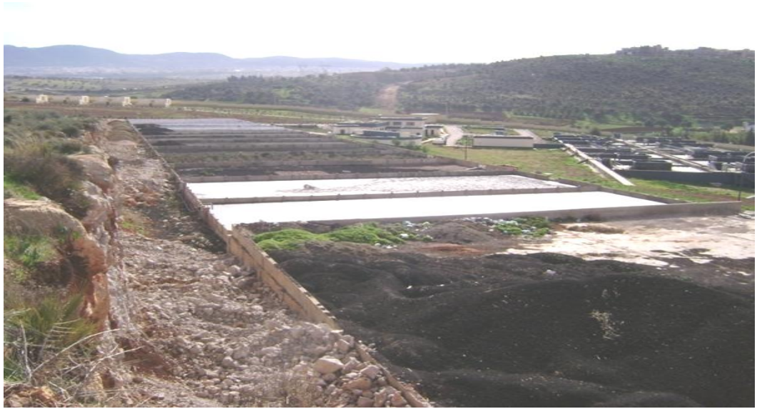
Figure II.17 : Lits de séchage +Aire de stockage des boues séchées
