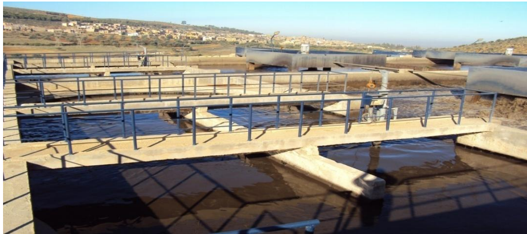
Photo II.11 : Zone non aérée dans le bassin d'aération
