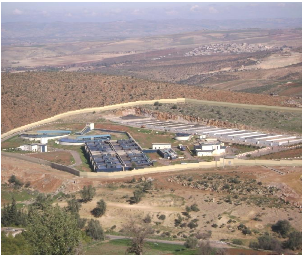
Photo II.1 : Panoramique de la station d'épuration des eaux usées de la ville de Tlemcen
