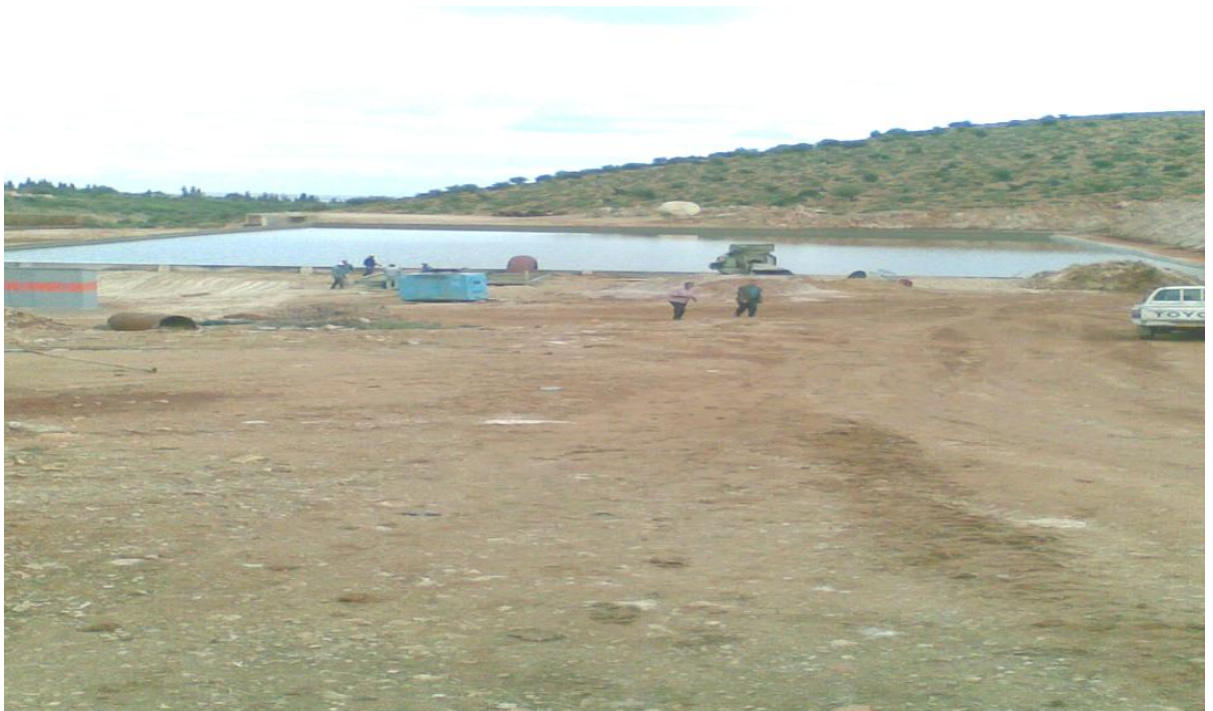
Photo II.18 : Réservoir de stockage des eaux usées épurées (bassin de l'ONID)
