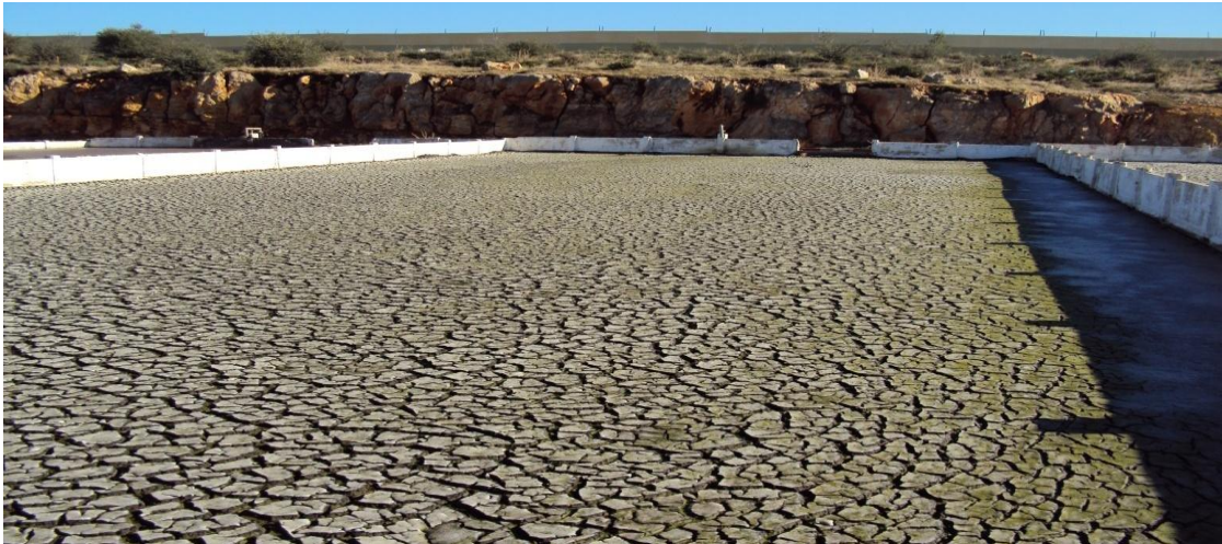
Photo II.16 : Lits de séchage
