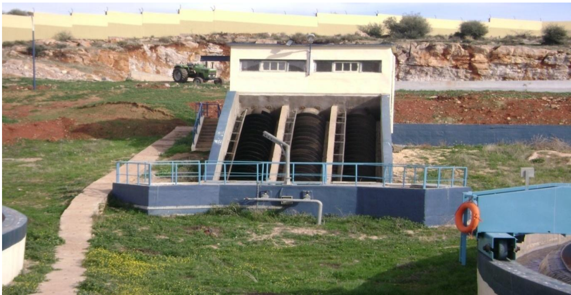
Photo II.14 : Vis de recirculation
