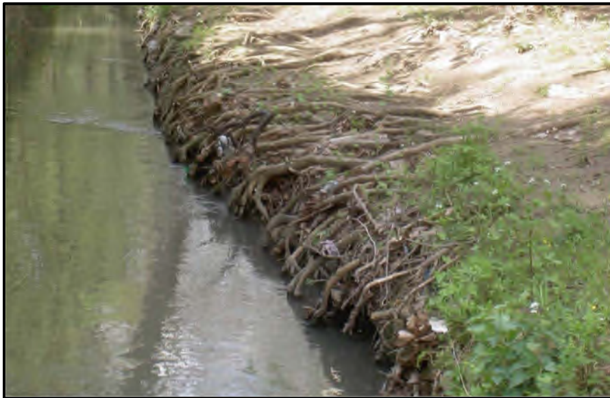
Photo II.3 : Aménagement des berges de l'oued contre le glissement (Halouche, 2007)
