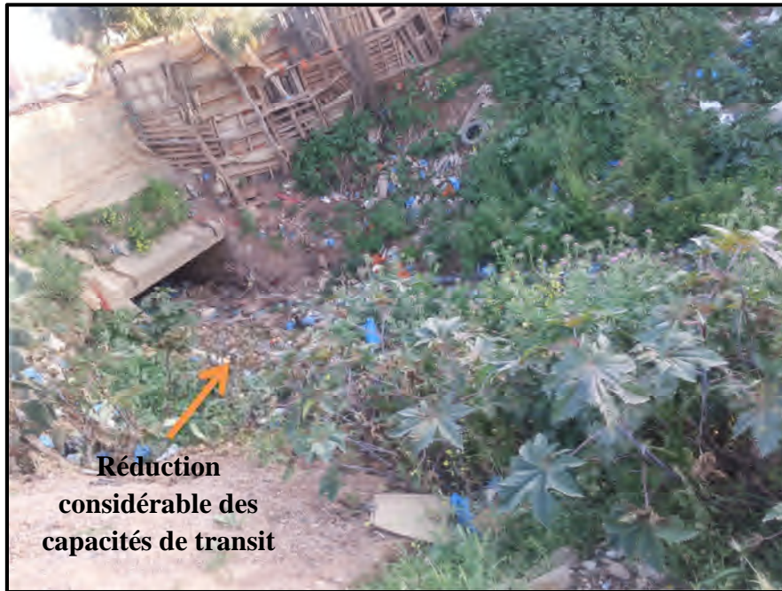
Photo III.6 : Ecoulement étranglé au niveau des singularités
