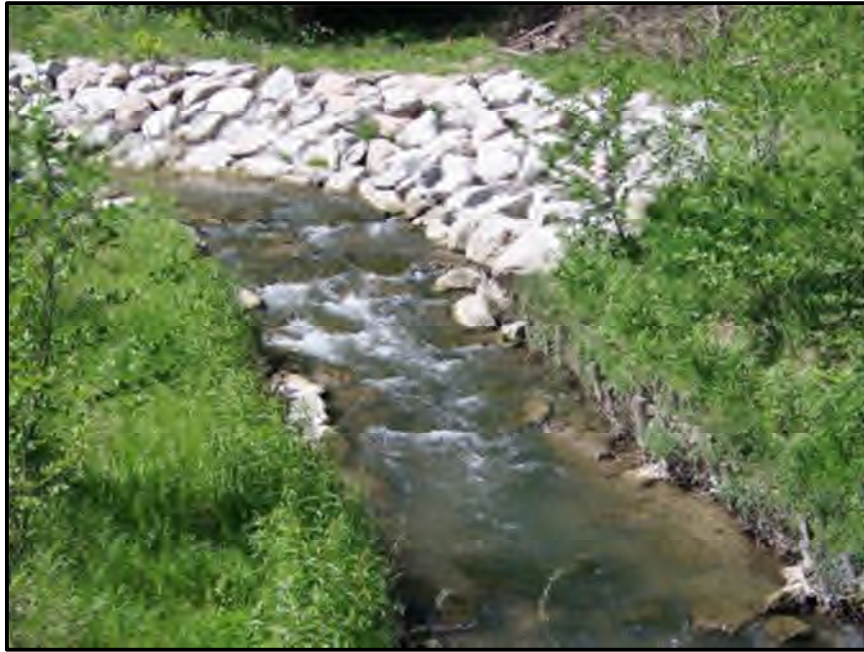
Photo II.2 : Digue enroché (www.geni-alp.org)
