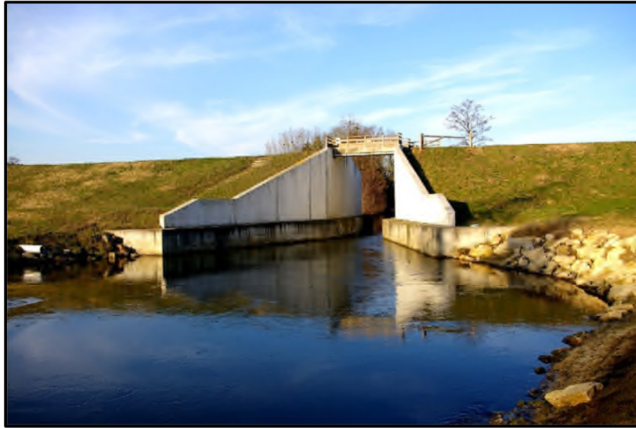
Photo II.5 Barrage écrêteur de crues sur l'Huisne (Talah, 2014)
