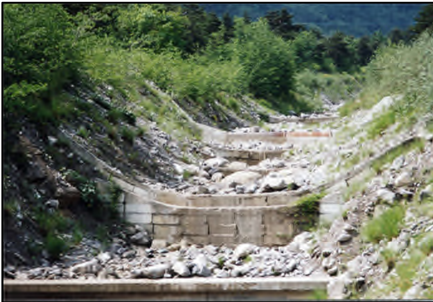
Photo II.6 Succession de seuils dans le chenal d'écoulement
