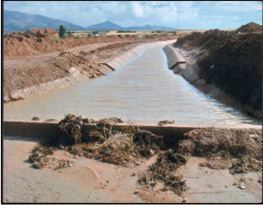
Photo IV.2 : Canal artificiel en béton (Abdeddaim, 2008)
