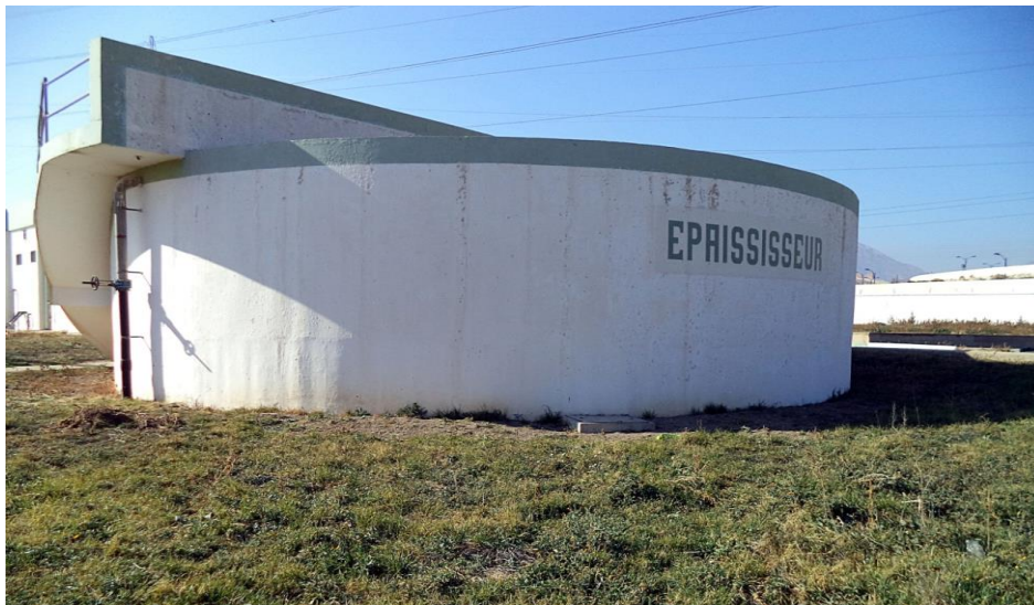
Figure III.14 : Photo de l'épaississeur
