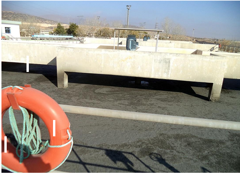
Figure III.13 : Photo du bassin de stabilisation
