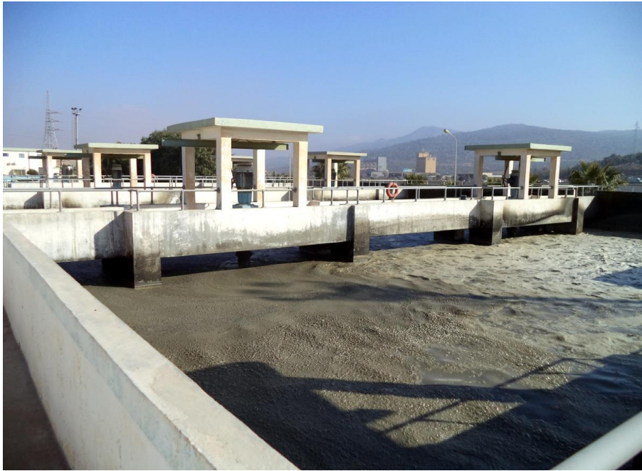
Figure III.09 : Photo du bassin d'aération.
