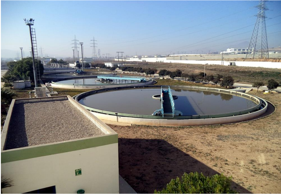
Figure III.10 : Décanteurs secondaires (Clarificateurs).
