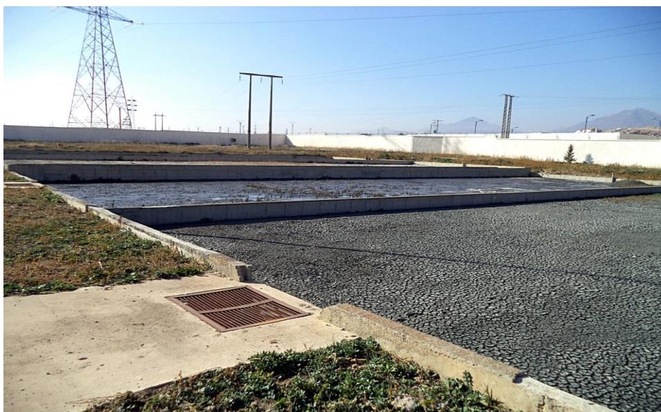
Figure III.16 : Photo des lits de séchage des boues
