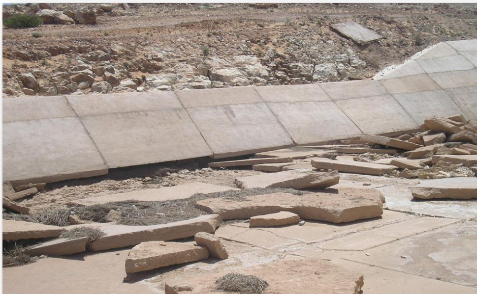
Photo 3.8 : dégradations du radier généralisée sur l'évacuateur des crues (CTH, 2006)
