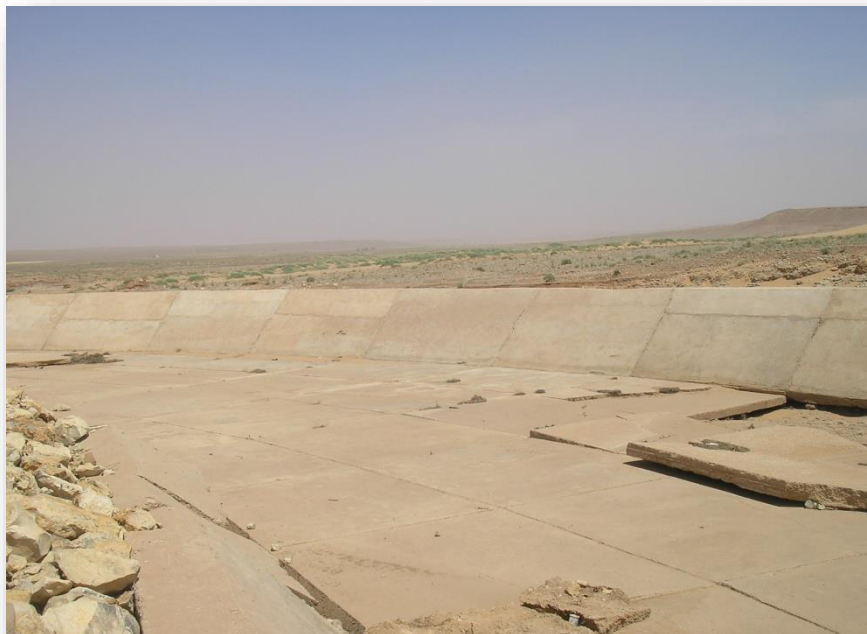
Photo 3.5 : Vues sur la partie courbe de l'évacuateur des crues (CTH, 2006)
