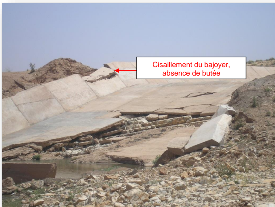
Photo 3.10 : Zone aval de l'évacuateur des crues, rapide à forte pente, présence de cavités et d'affaissement du radier (CTH, 2006)
