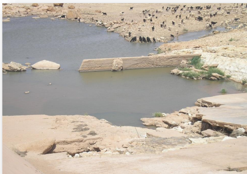
Photo 3.12 : Bassin de dissipation détérioré (CTH, 2006)
