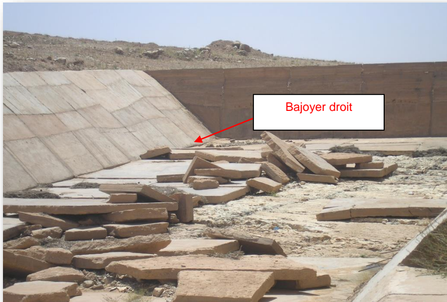
Photo 3.6 : Tranchée déversante : détérioration complète du radier et entraînement des dalles (CTH, 2006)
