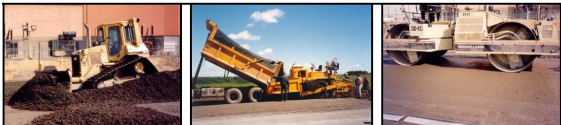
Photo 2.3 : Equipement du compactage du BCR
