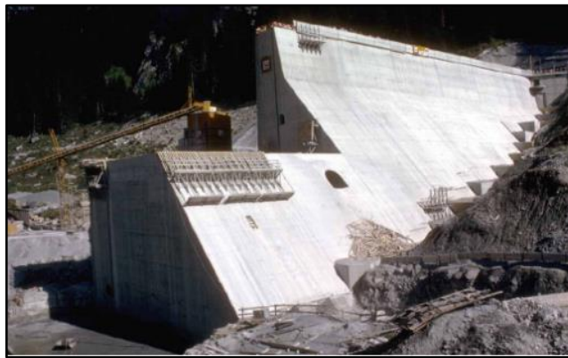
Photo 2.2 : Construction d'un barrage poids
