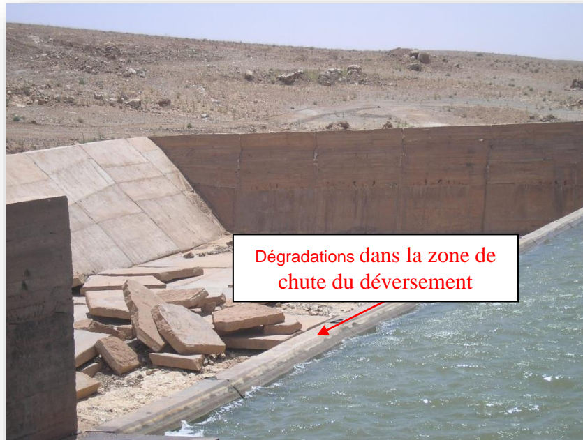
Photo 3.4 : Dégradation dans la zone de déversement de l'évacuateur des crues (CTH, 2006)
