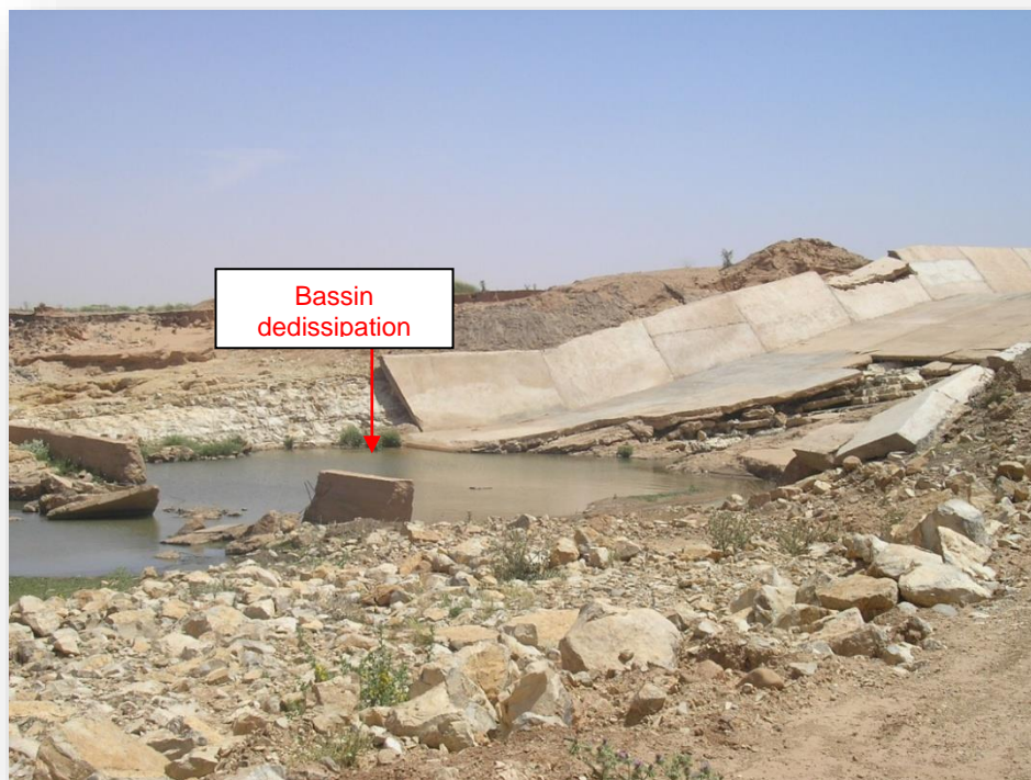
Photo 3.12 : Bassin de dissipation détérioré (CTH, 2006)
