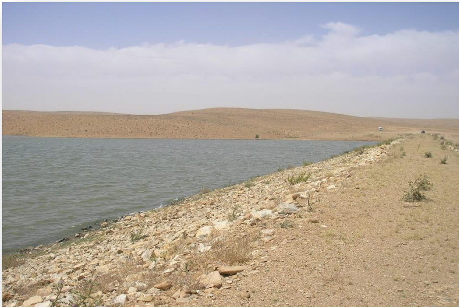
Photo 3.1 : Vue générale sur le parement amont du barrage avec le lac (CTH, 2006)
