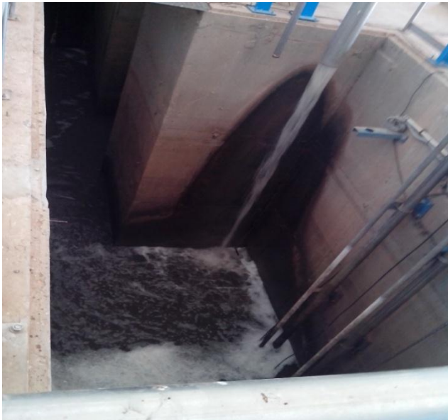
Figure III.4 : piège à sable
