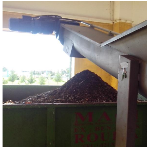
Figure III.5 : évacuation des sables
