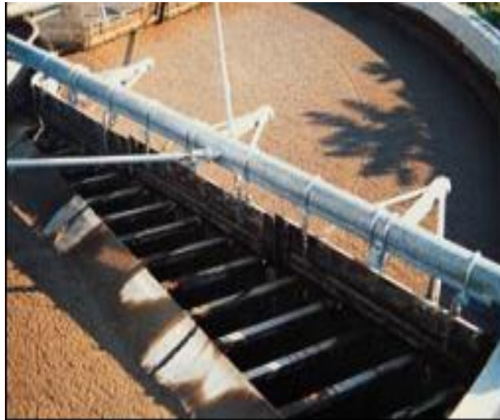
Figure II.13 : Etape d'épaississement des boues par flottation [46].
