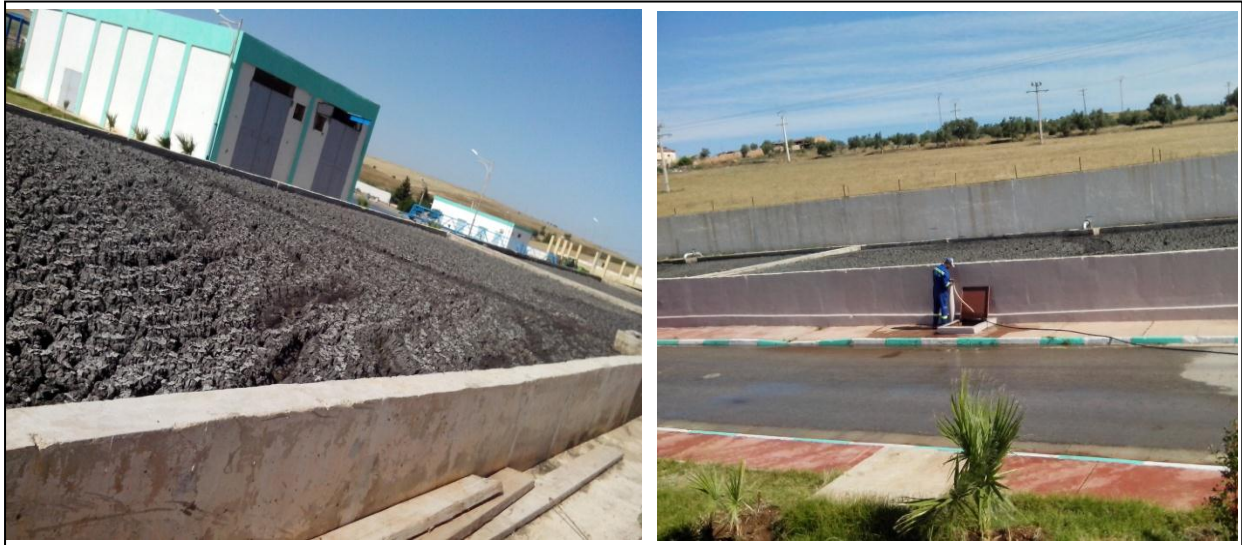
Figure III.15 : lits de séchage
