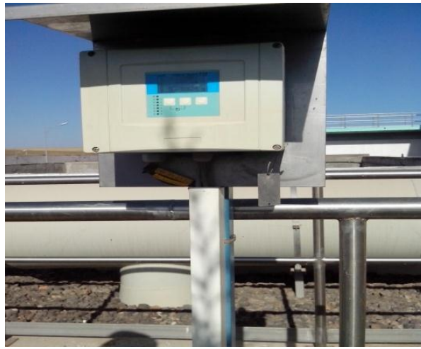
Figure III.7 : Débitmètre à ultrason
