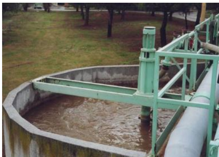
Figure II.4: Photo d'un dessableur [a5].
