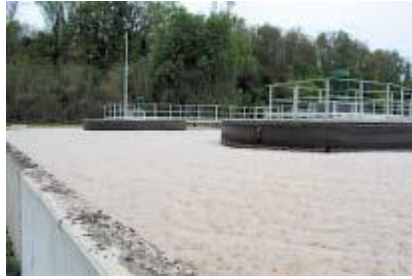
Figure II.15 : Mousse biologique en surface de bassin d'aération [10]
