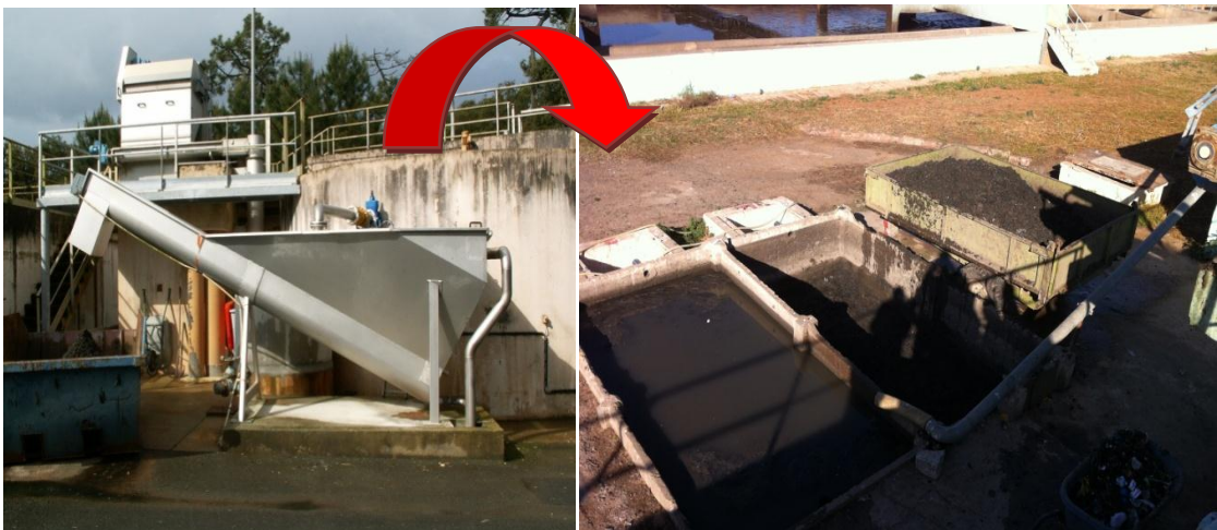
Figure V.3 classificateur à sable
