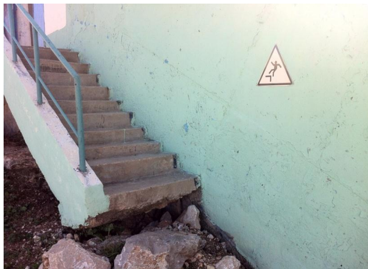
Figure IV.18 : Photo de l'escalier de la chambre des moteurs vers des vis d'Archimède
