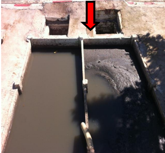
Figure IV.12 : Les bacs à sable
