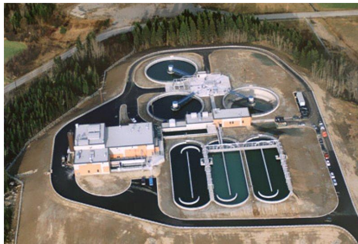
Figure II.6: Photo des bassins à boucle fermées [13]
