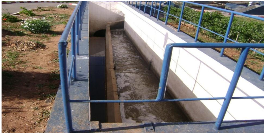
Figure III.2: Photo du déversoir d'orage.
