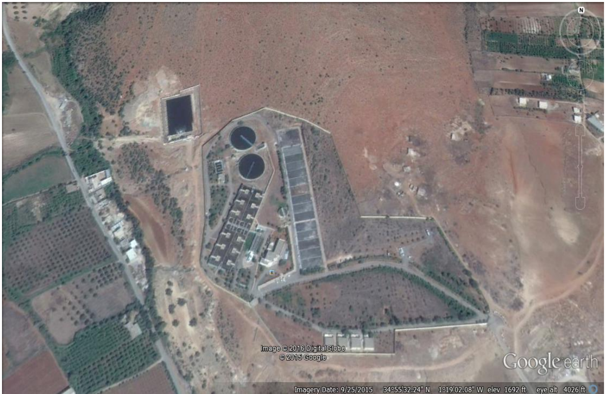
Figure III.1: Vue de la Station d'épuration d'Ain El Houtz (Tlemcen)
