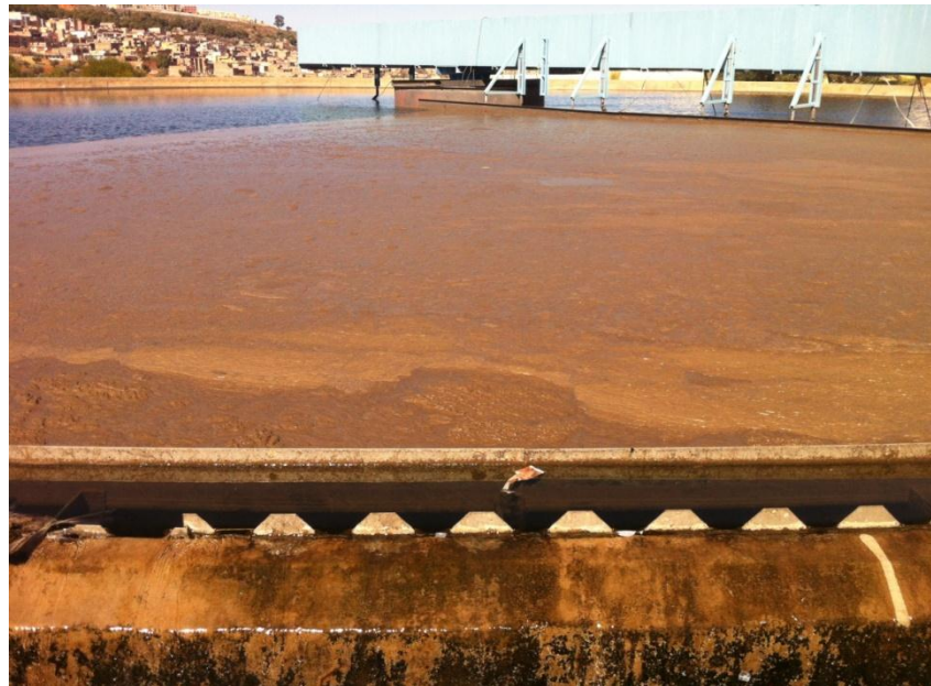
Figure IV.7 : Clarificateur de la STEP Ain El Houtz le 29/02/2016
