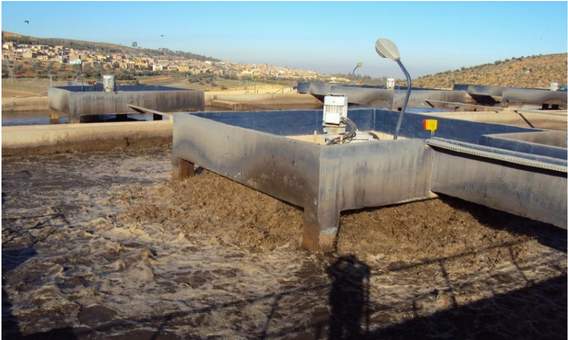
Figure III.8: Photo du bassin d'aération
