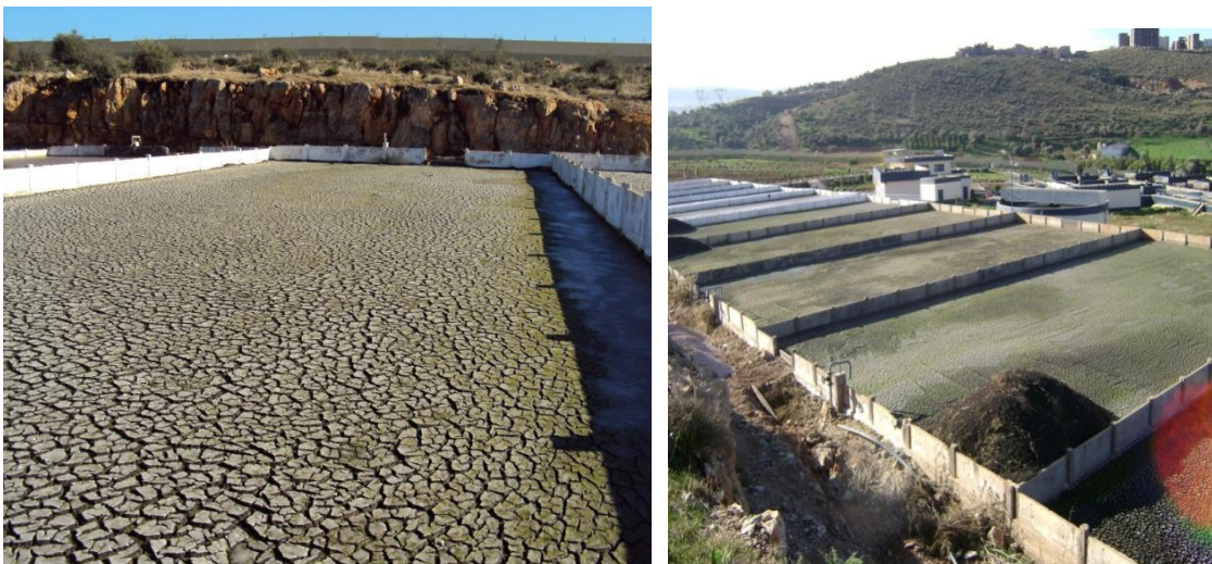
Figure III.14 : Photo des lits de séchage
