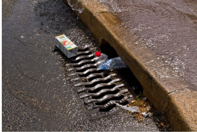
Figure IV.10. Photo sur les déchets transportés par les effluents via les avaloirs de la voirie
