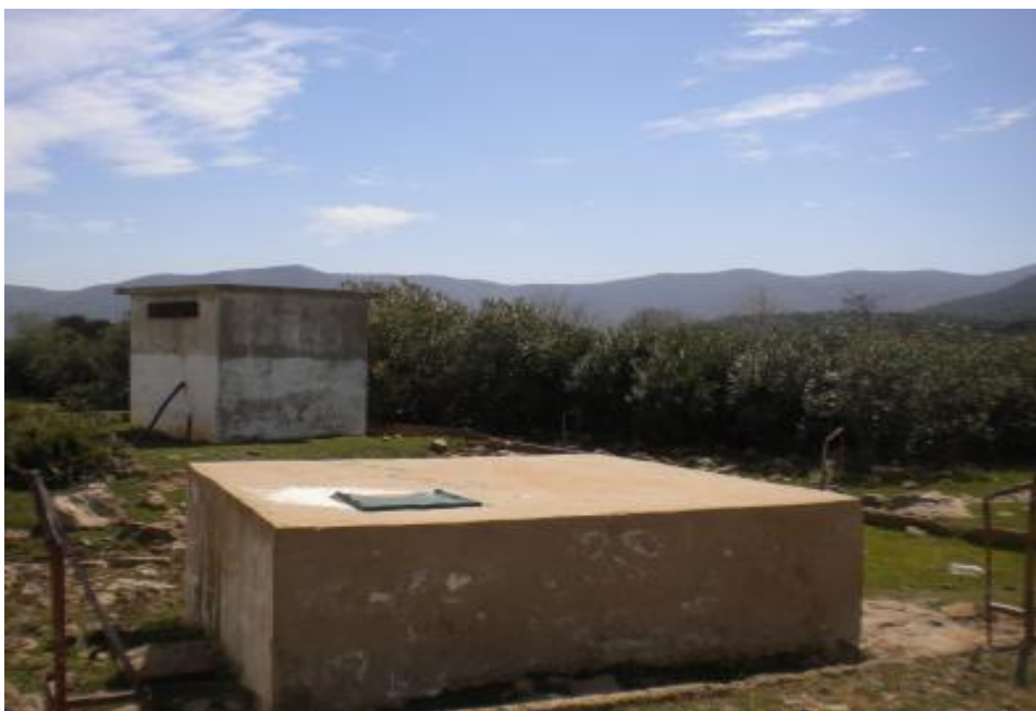
Figure III. 1 : Captage de la source d'Ain Souiga
